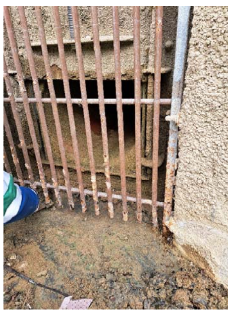
Reja de barrotes de acero dispuesta tras la rejilla indicada en la imagen de la izquierda
