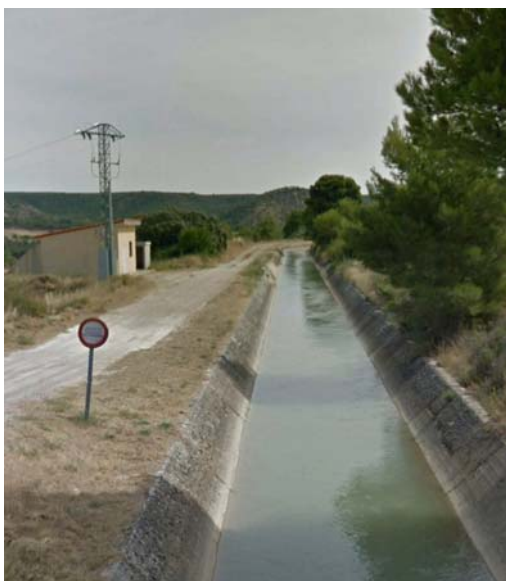
Situación del edificio de bombeo respecto del canal
