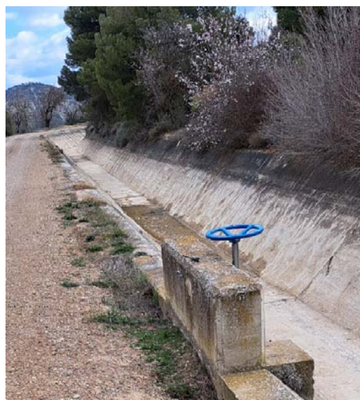
Obra de toma con maniobra desde el camino
