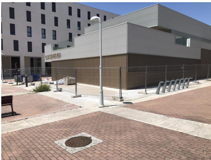
Punto de instalación
