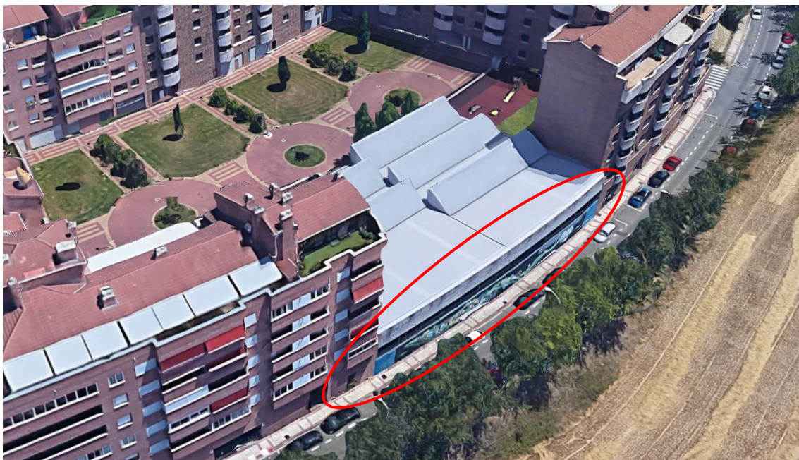
Ubicación de la terraza exterior cuyo pavimento es necesario reparar.
