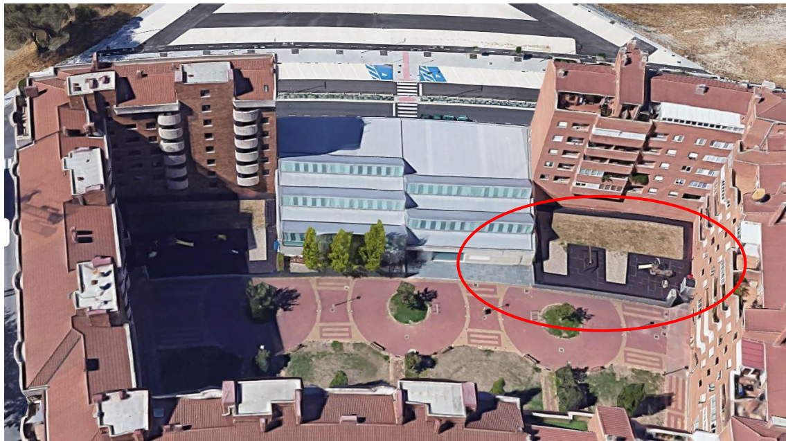
Ubicación del patio exterior en el que se sitúa el pavimento de caucho en losetas. Si bien existen dos patios, se plantea únicamente la actuación en uno de ellos, que es el más deteriorado.
