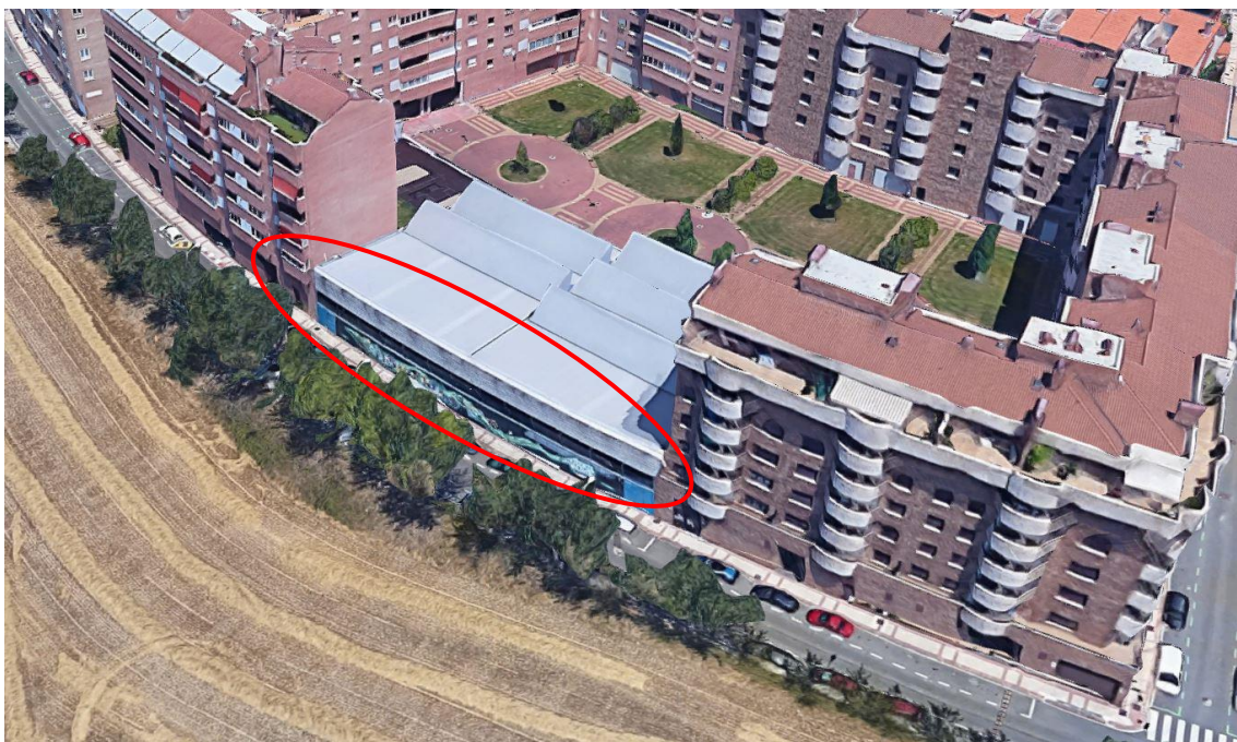
Ubicación de la terraza exterior cuyo pavimento es necesario reparar.
