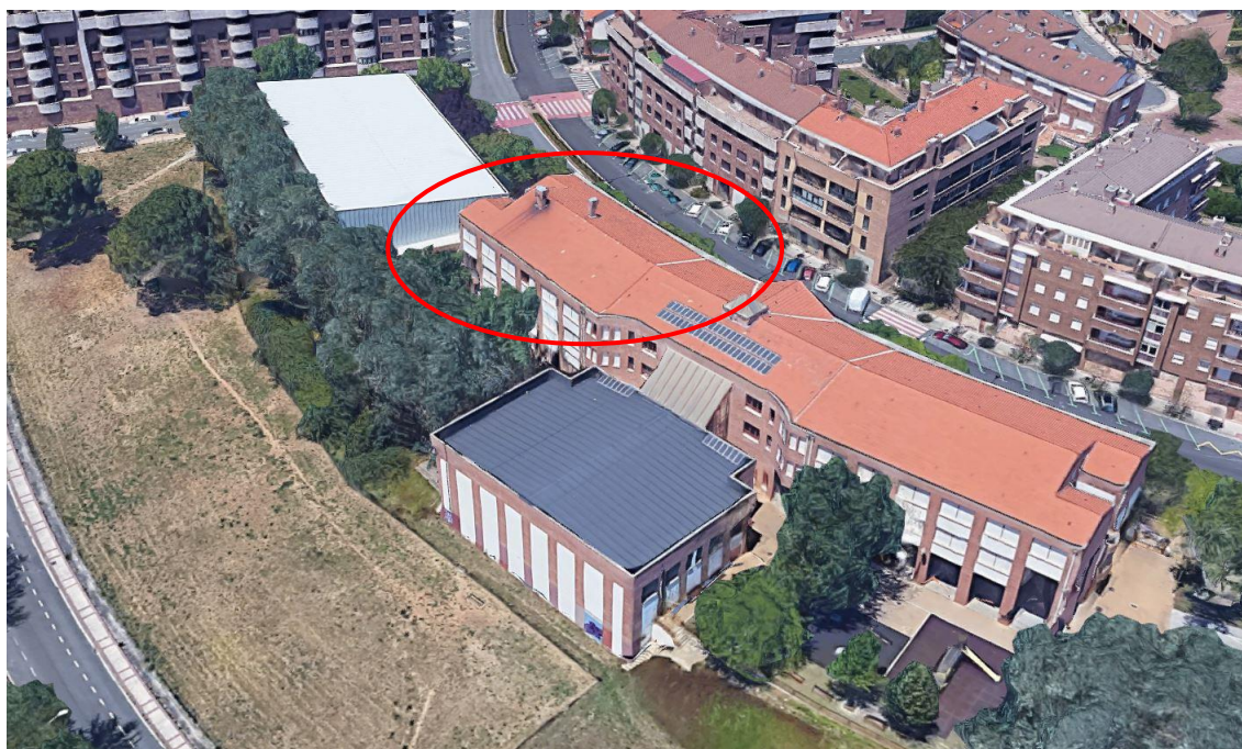
Parte de la cubierta que presenta los problemas de filtraciones donde se localizan las filtraciones.
