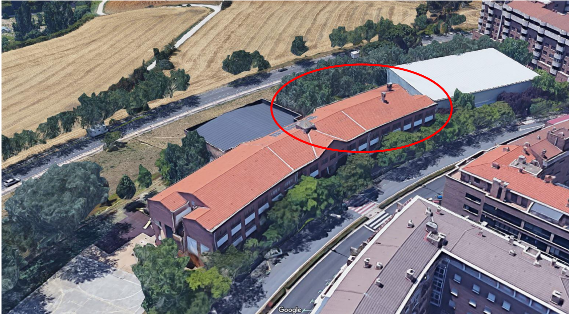
Parte de la cubierta que presenta los problemas de filtraciones donde se localizan las filtraciones.
