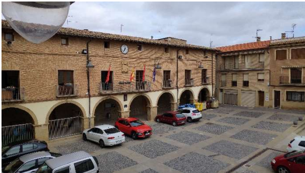
Fig 2.3 Fachada Casa Consistorial (Plaza de los Fueros)
