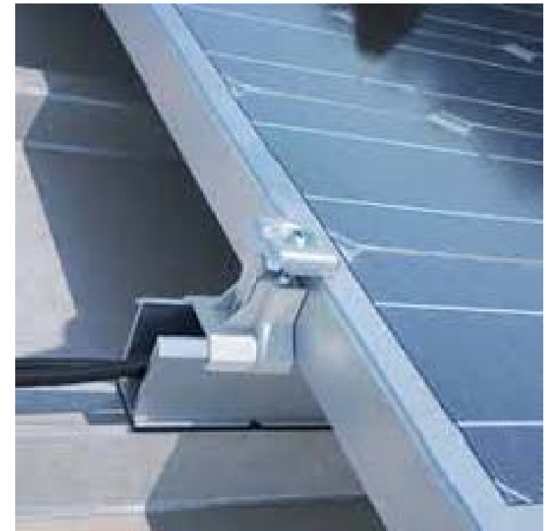
DETALLE SUJECIÓN PANEL CUBIERTA METÁLICA
