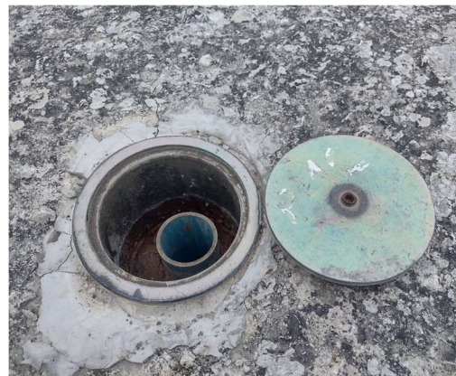
Imágenes 3 y 4. Detalle de piezómetros del dique en los que se instalar las sondas de medición de nivel de aguas subterráneas.
