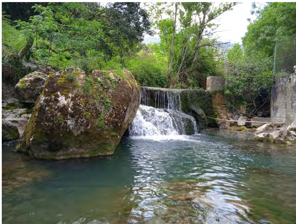
Aspecto presa de aguas abajo a demoler (ARK-UD-06) en el río Udarbe
