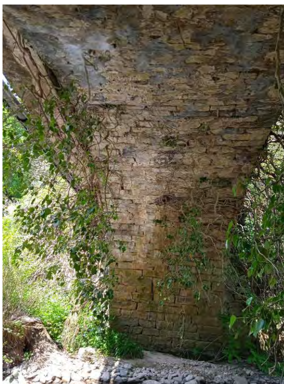
Estado actual paramento inferior puente en el río Udarbe
