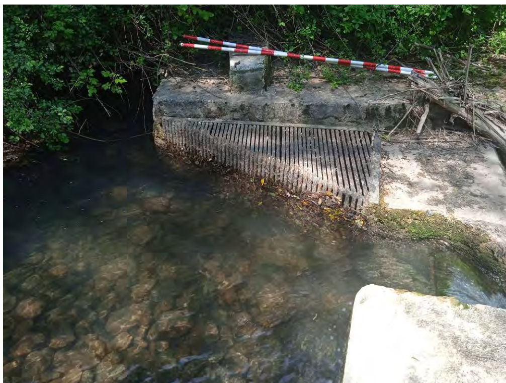
Imagen toma de agua para piscifactoría y actual escotadura en presa en el río Udarbe
