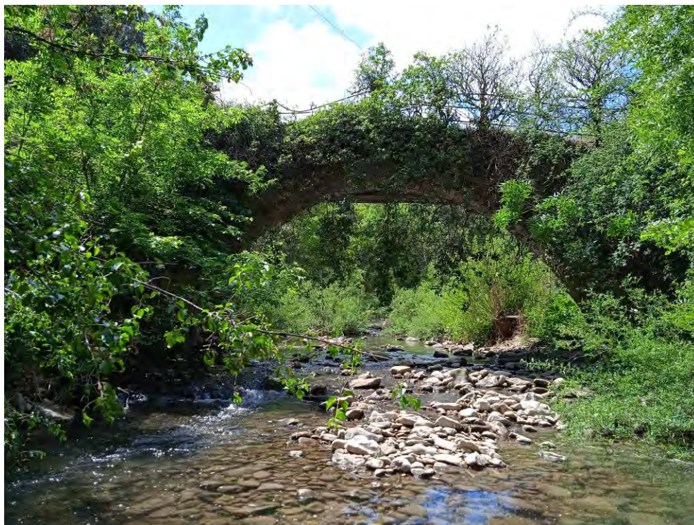
Imagen del puente desde aguas abajo en el río Udarbe
