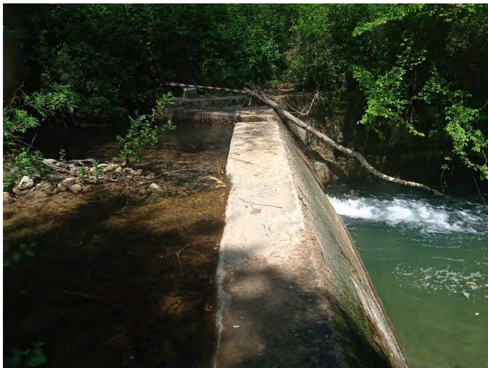
Coronación presa ARK-UD-05 en el río udarbe
