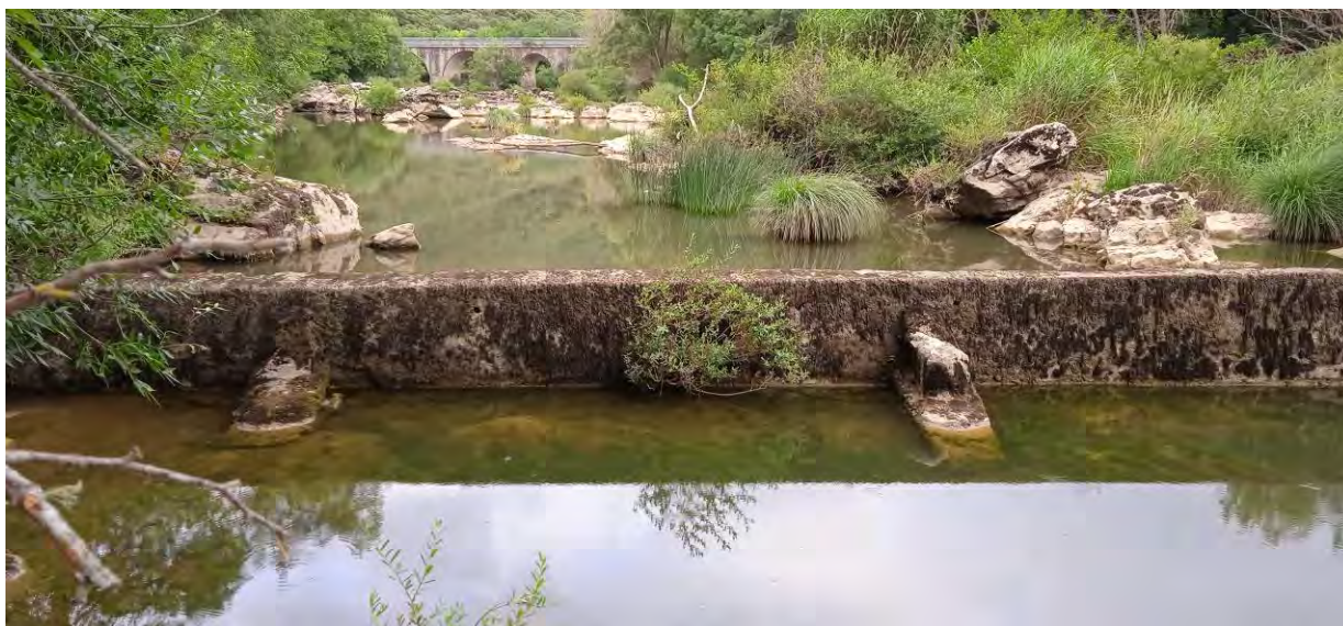
Presa/obstáculo parcial a demoler en el río Arakil
