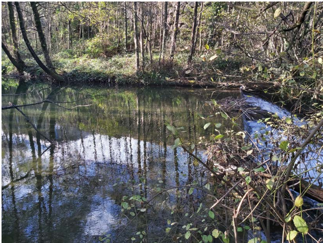
Trasdós de Presa Colmatado
