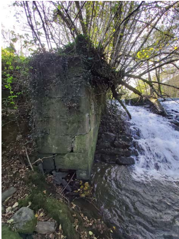
Machón de sillería en Margen Derecho
