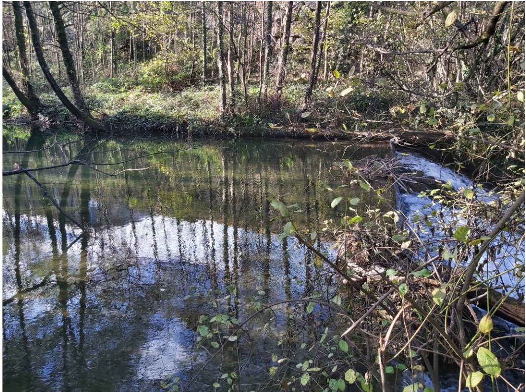
Trasdós de Presa Colmatado
