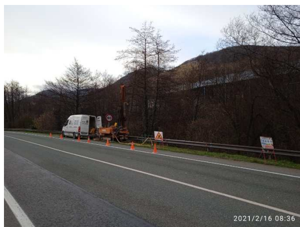
Foto 2.- Emplazamiento sondeo S2
