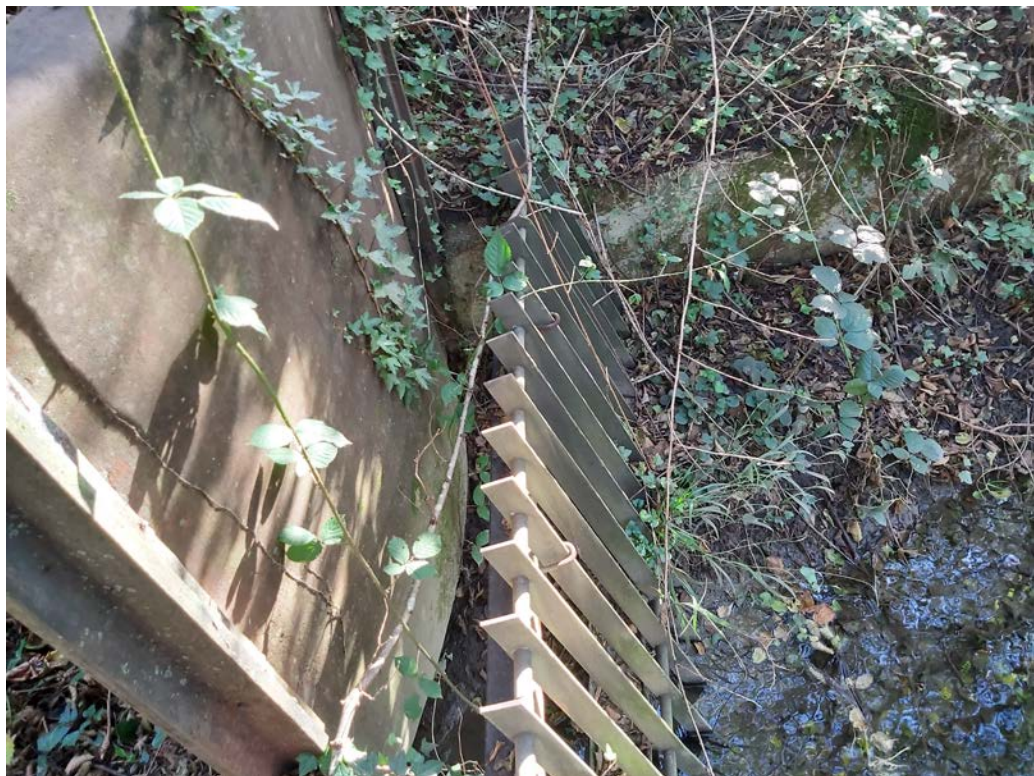
Canal de Derivación
