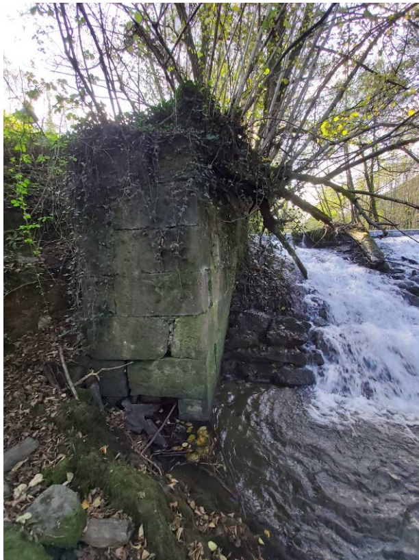
Machón de sillería en Margen Derecho
