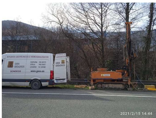
Foto 1.- Emplazamiento sondeo S1
