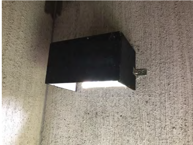
Ventana con caja de madera negra invertida para reducir el paso de la luz.
