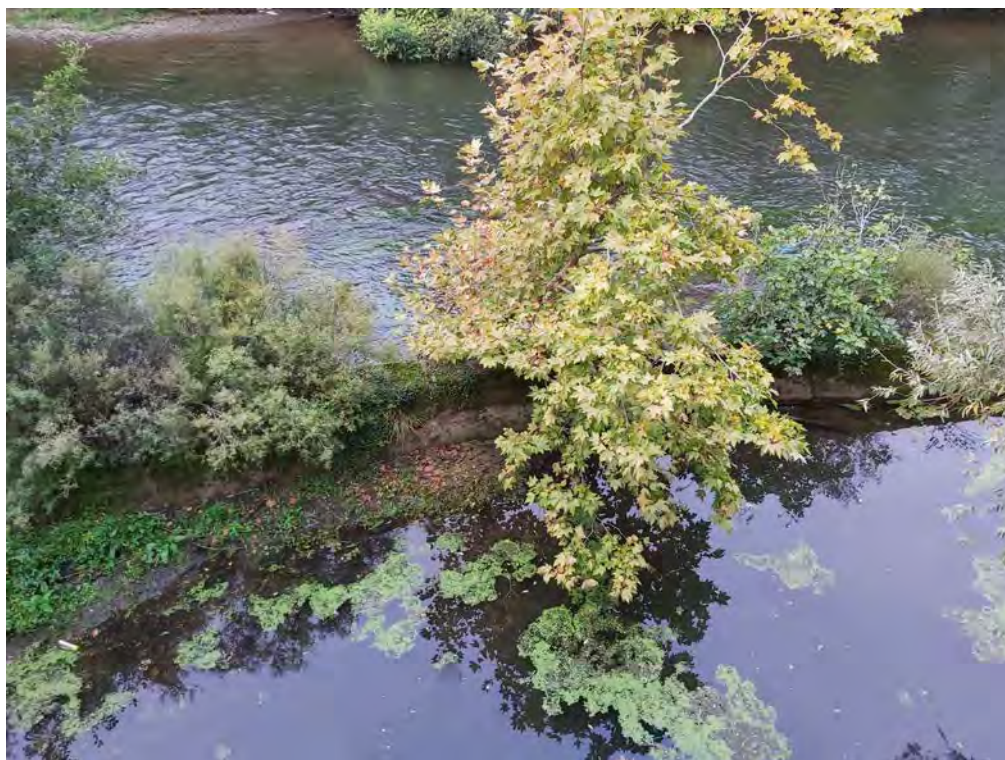
Muros de contención
