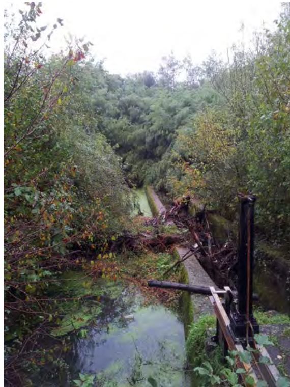
Canal Existente entre central y marco existente
