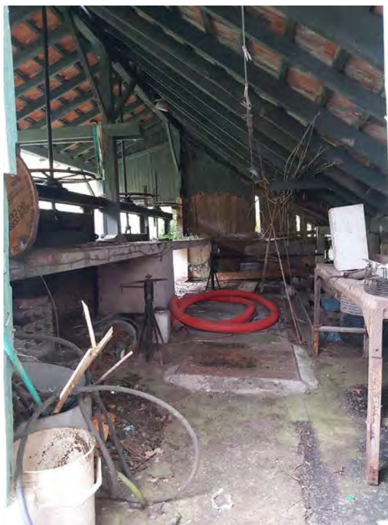
Nave de almacenaje
