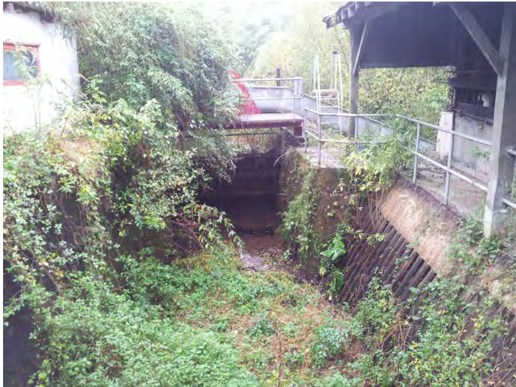
Canal Existente en entrada a central
