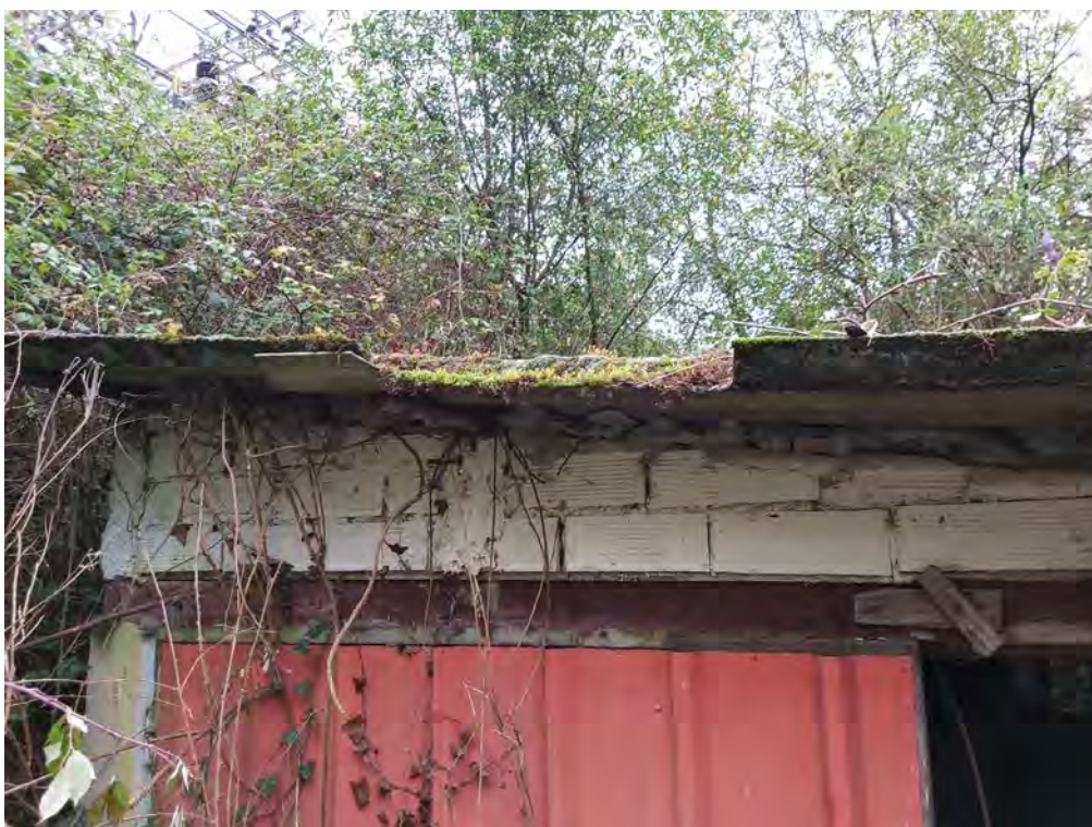
Edificación y tejavana con placas de fibrocemento en entrada de central
