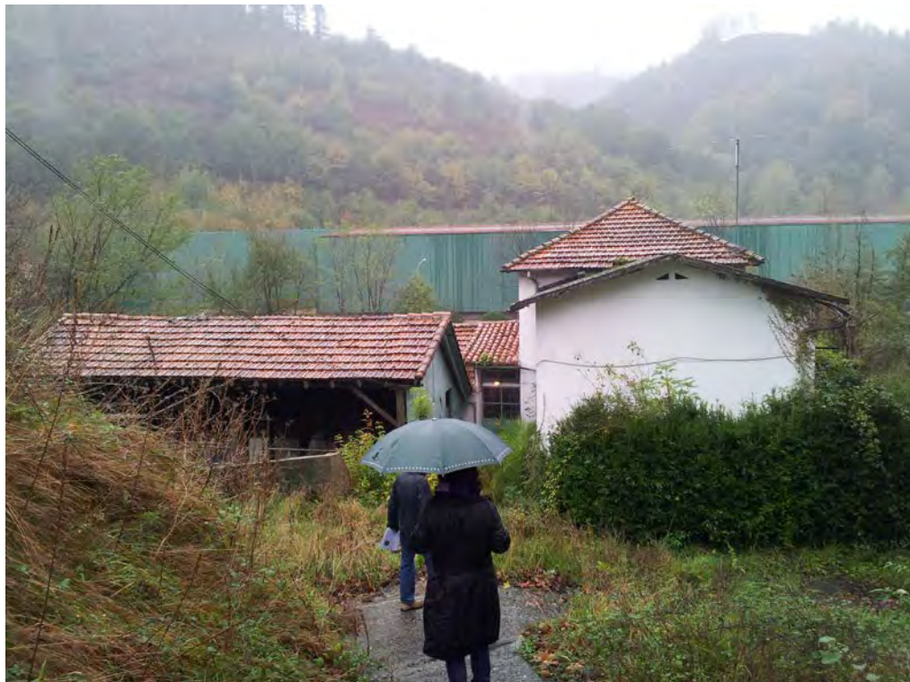
Aspecto General Central Hidroeléctrica
