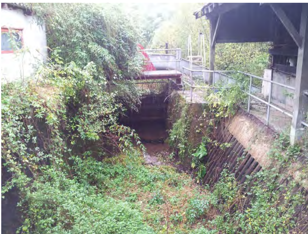
Canal Existente en entrada a central
