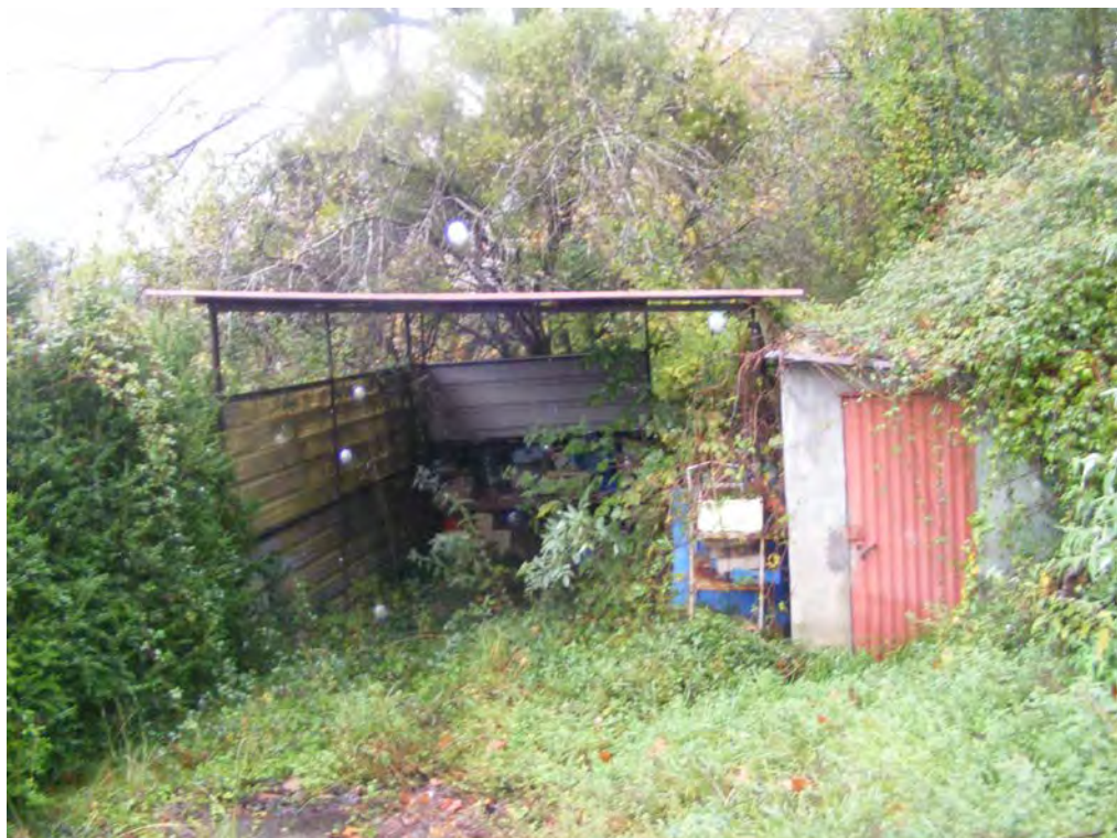
Edificación y tejavana Metálica en entrada de central
