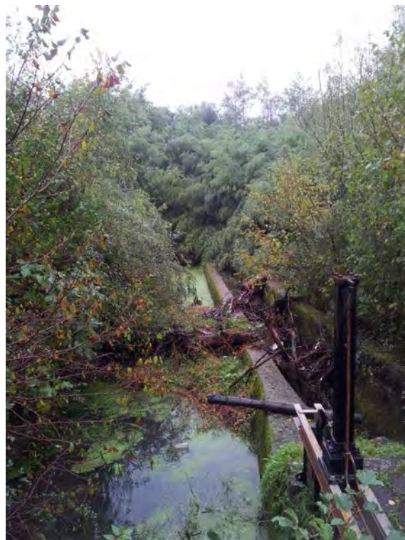
Canal Existente entre central y marco existente
