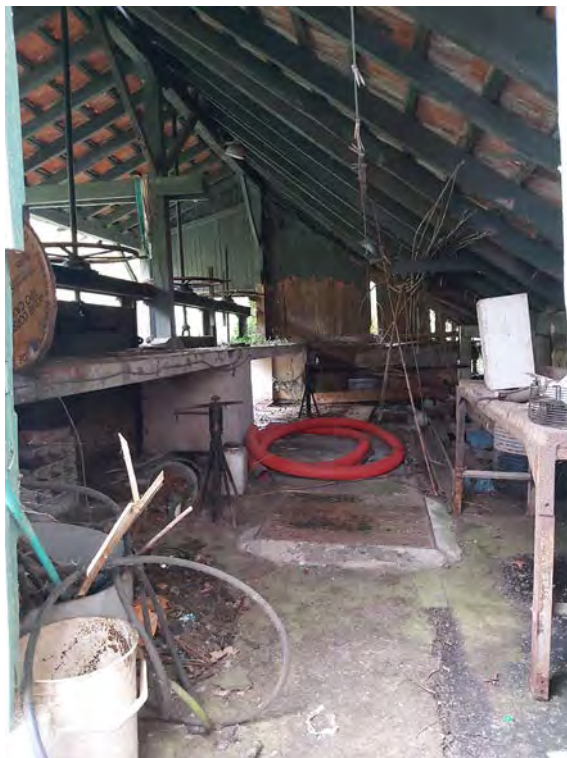
Nave de almacenaje
