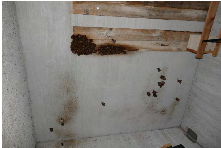
Ejemplo de tablas de madera en parte del techo de una caseta, para facilitar el agarre de los murciélagos. Se observa un grupo colgando del borde de estas tablas, mientras otros murciélagos cuelgan directamente del hormigón.
