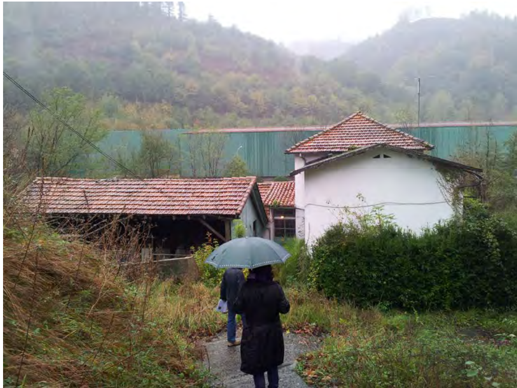
Aspecto General Central Hidroeléctrica
