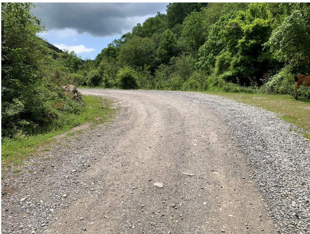
FOTOGRAFÍA 6: Ubicación nueva obra de fábrica (2 Tubos Hormigón Diámetro 1.800 mm).
