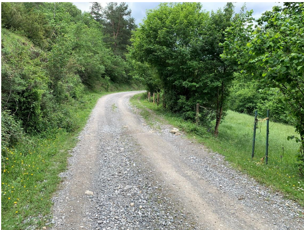
FOTOGRAFÍA 7: Vista general del camino de Azparren a Aristu.
