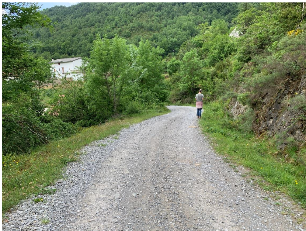
FOTOGRAFÍA 2: Vista general del camino de Azparren a Aristu.
