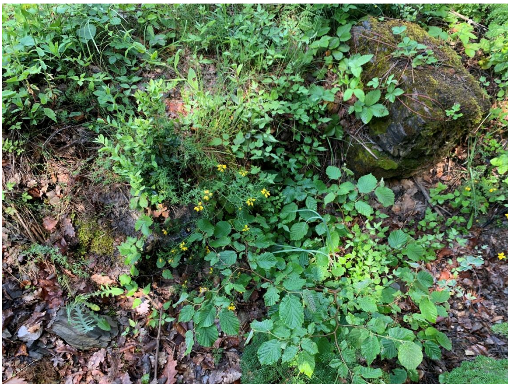
FOTOGRAFÍA 11: Caños con vegetación en la embocadura y cegados.
