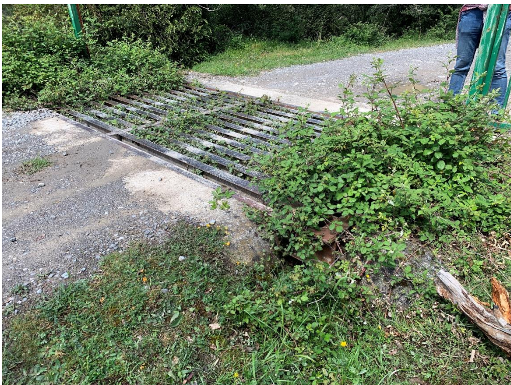
FOTOGRAFÍA 12: Paso canadiense a acondicionar, limpieza de la vegetación.
