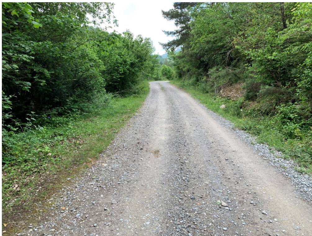
FOTOGRAFÍA 4: Vista general del camino de Azparren a Aristu.
