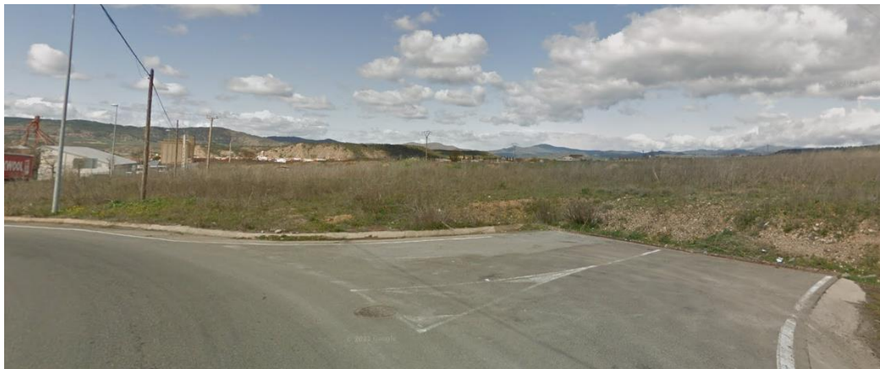
Fotografía de la zona de estudio vista desde la carretera de acceso a Carcastillo.
