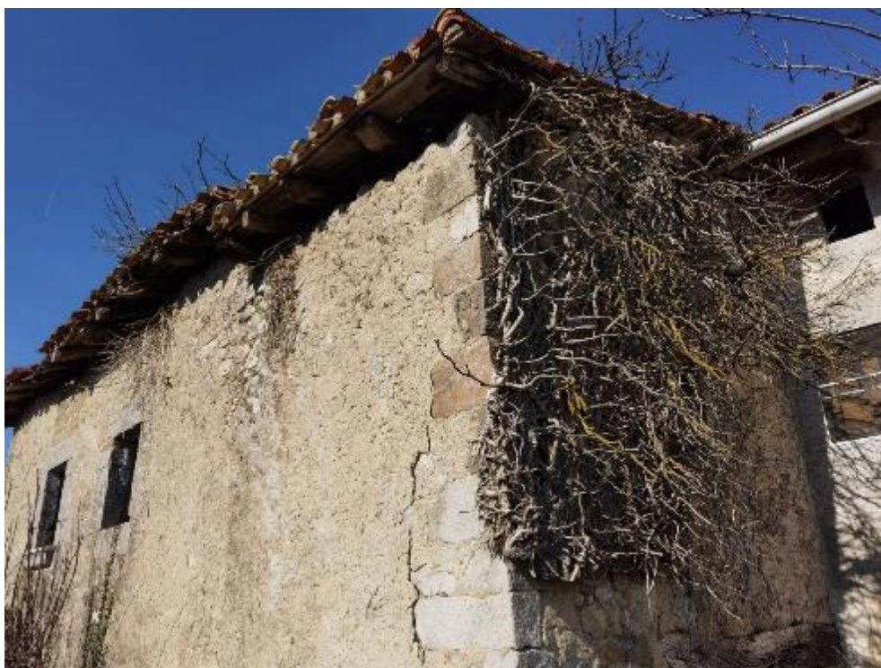
fachada posterior (sur)
