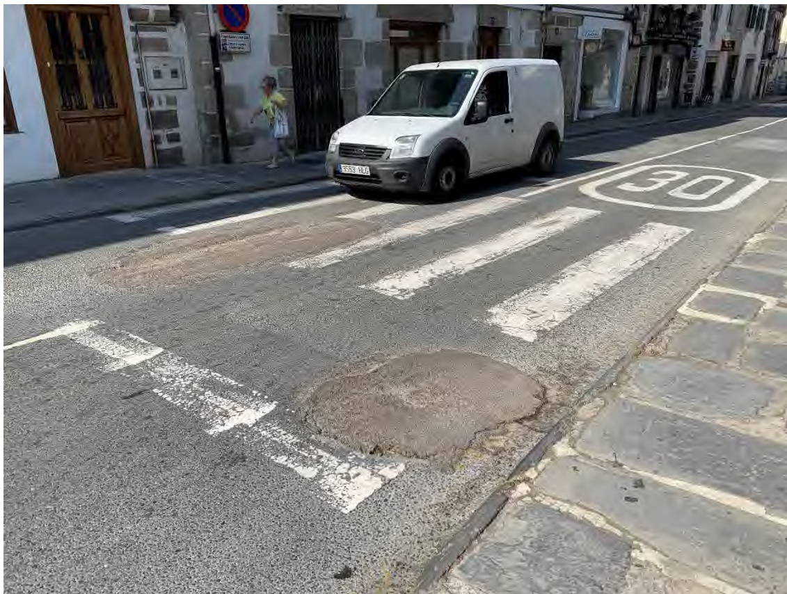
FOTOGRAFÍA 21: Parche de reparación de fuga en calzada. En paso de peatones no accesible y sin señalización de ningún tipo, excepto la horizontal en mal estado.
