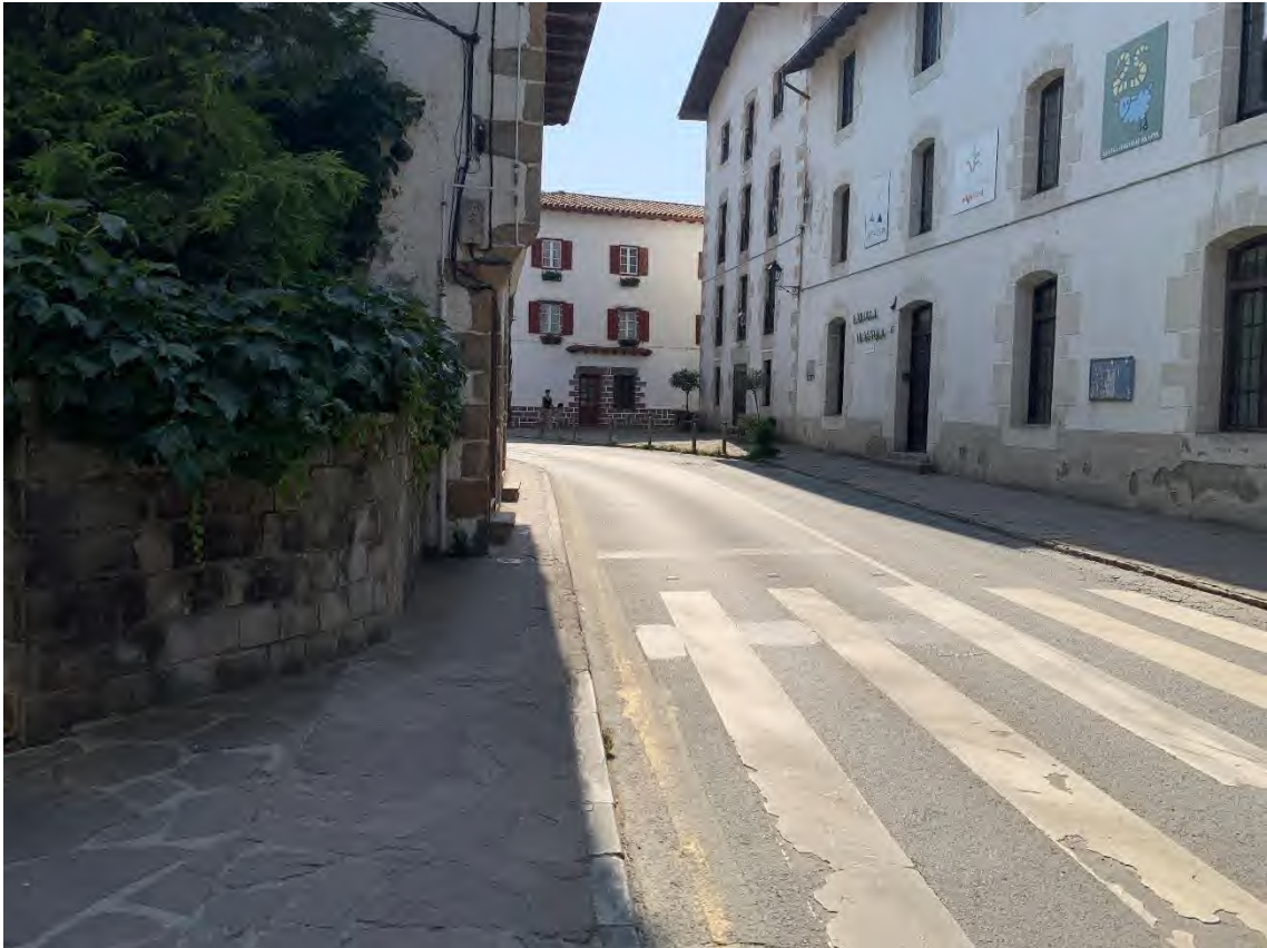
FOTOGRAFÍA 11: Estrechamiento de la acera en el acceso al portal, junto al paso con bordillo de 15 cm, hace que no hay accesibilidad desde el resto de la localidad sino es por la calzada. Paso peatonal sin señalización vetical.
