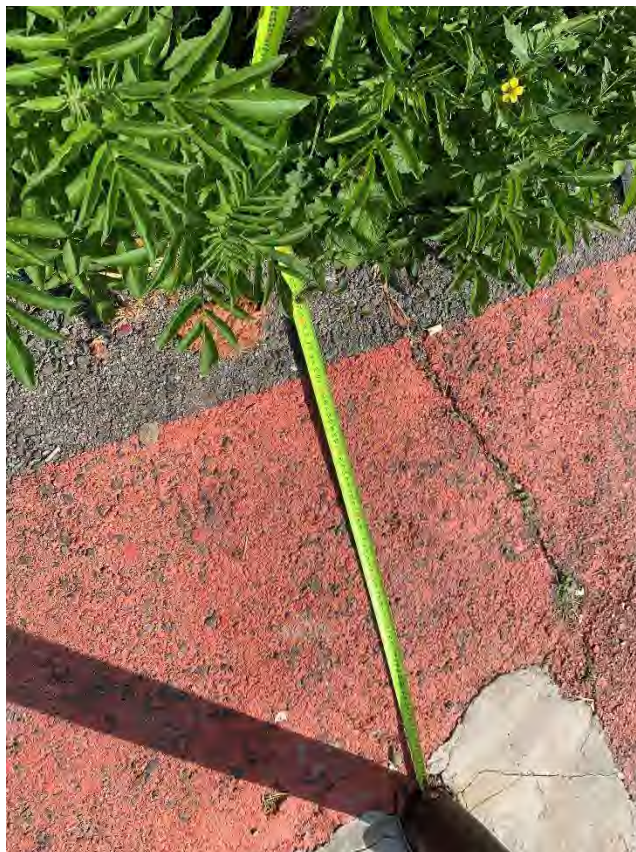
FOTOGRAFÍA 15: Anchura del paso, incluyendo la vegetación que invade la anchura útil.
