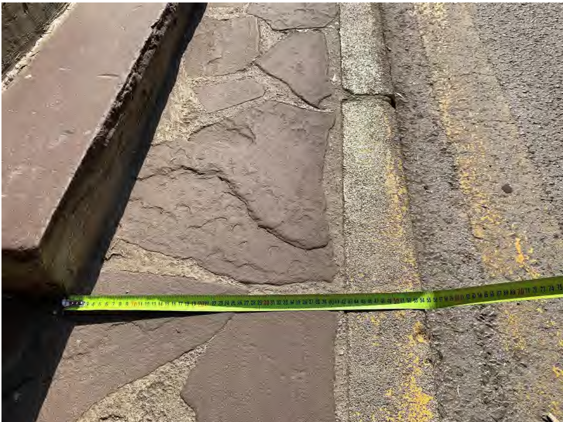
FOTOGRAFÍA 12: Anchura máxima frente al portal 9.
