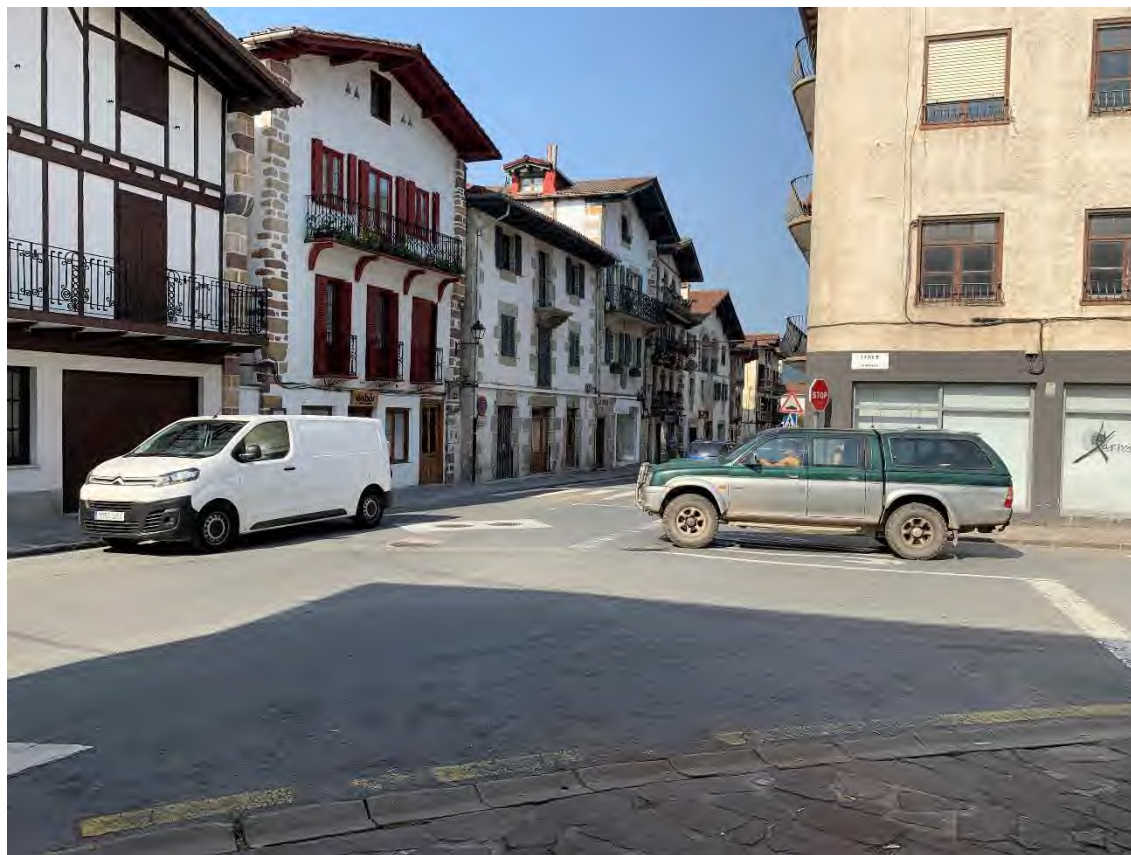
FOTOGRAFÍA 22: Entronque de Altzate con la plaza homónima e Iztea. Pasos peatonales no accesibles y pavimento en mal estado.
