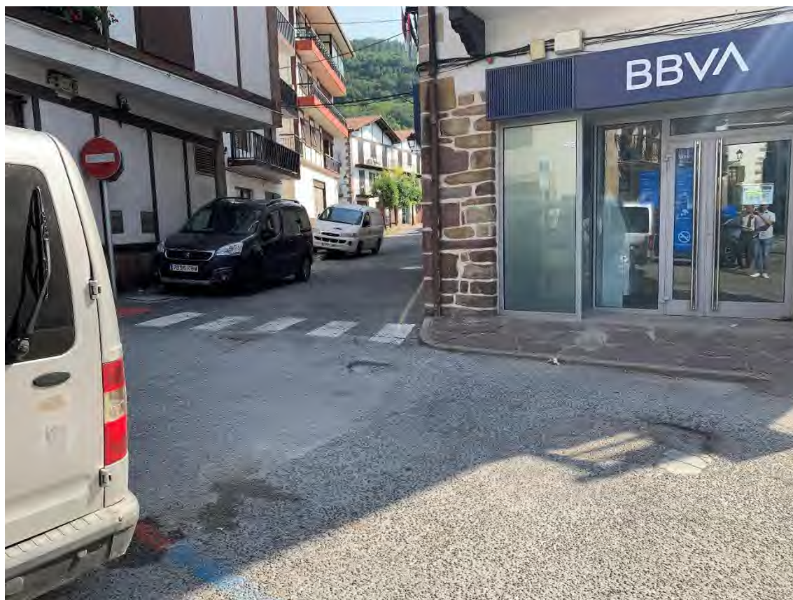
FOTOGRAFÍA 17: Discontinuidad de aceras y paso peatonal entre los portales 15 y 17 de Altzate, así como con Iparraldea Karrika.
