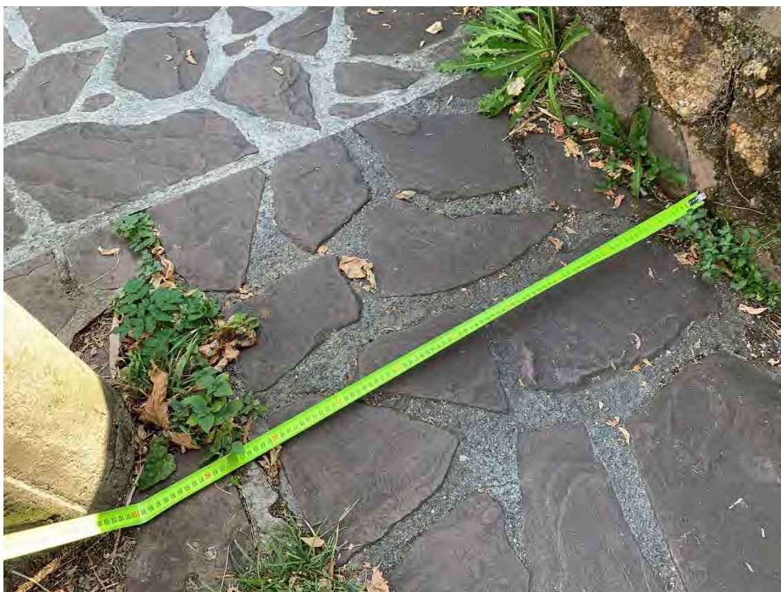
FOTOGRAFÍA 4: Paso de 90 cm de anchura que queda.
