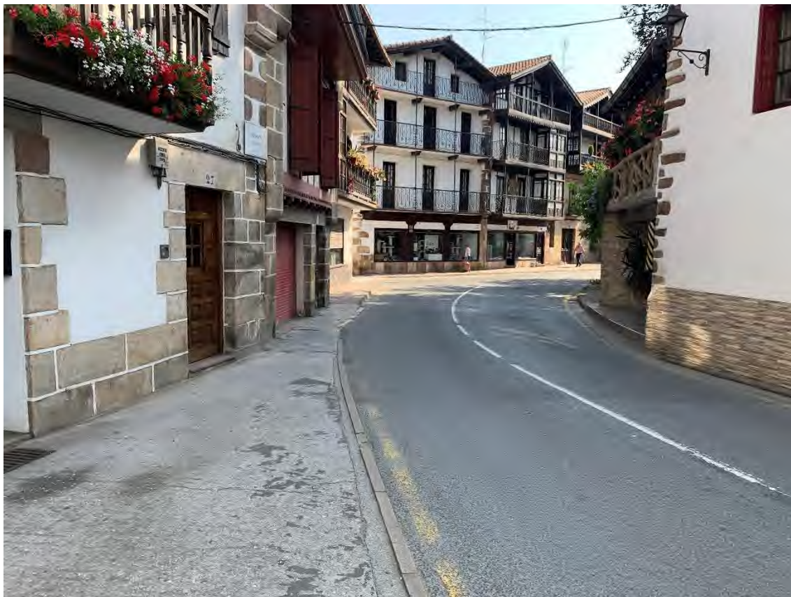
FOTOGRAFÍA 7: Acera muy estrecha frente a los portales 29 y 31 de Eztegara. El acceso al portal 6 de Alzate es por la calzada de la travesía. Además, con un considerable escalón para evitar la entrada de agua al portal, ya que el peralte y evacuación del agua es hacia este punto.
