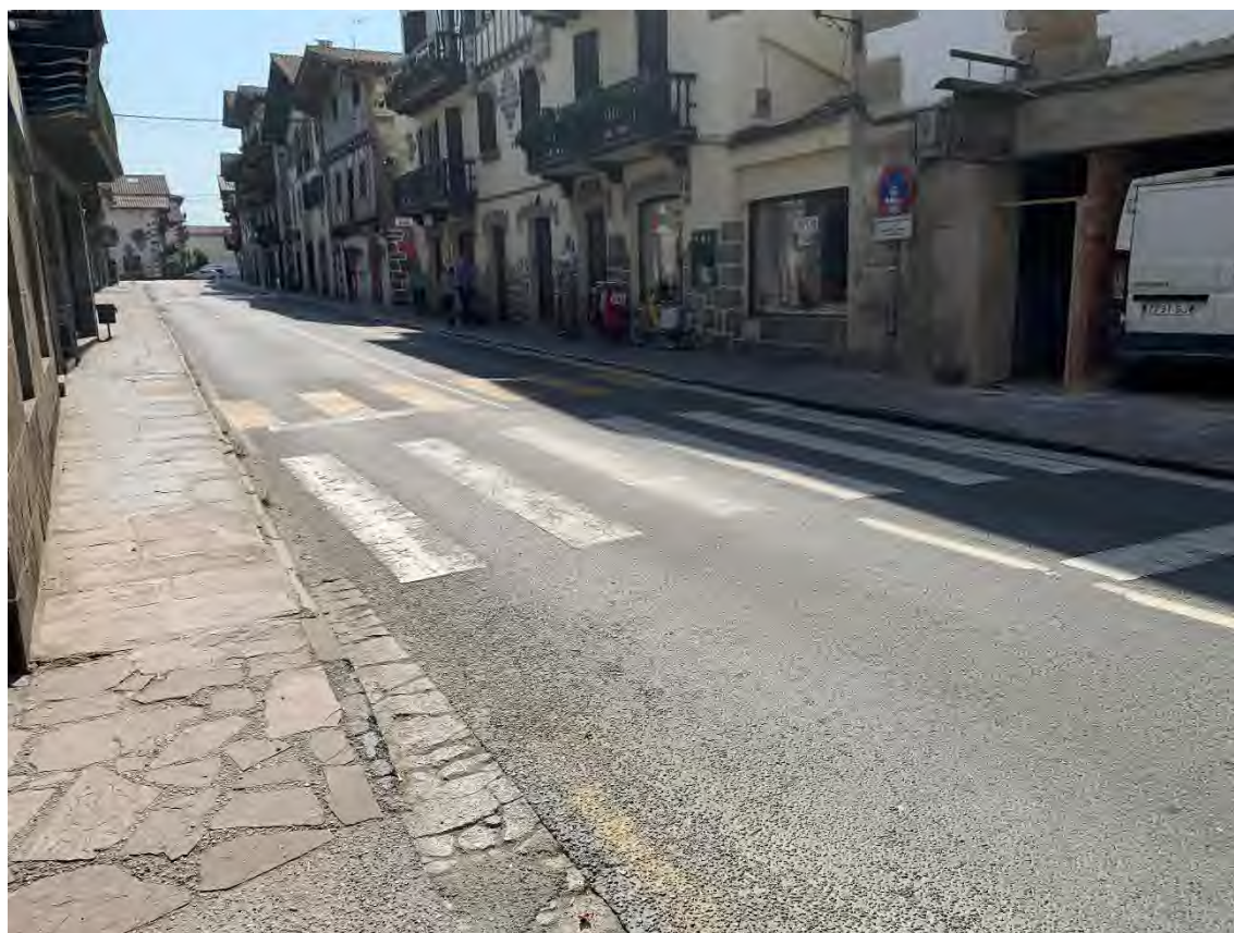
FOTOGRAFÍA 18: Acera desde el portal 17 a 33, con dos pasos consecutivos que no son accesibles. Sin señalización vertical y la horizontal muy degradada.
