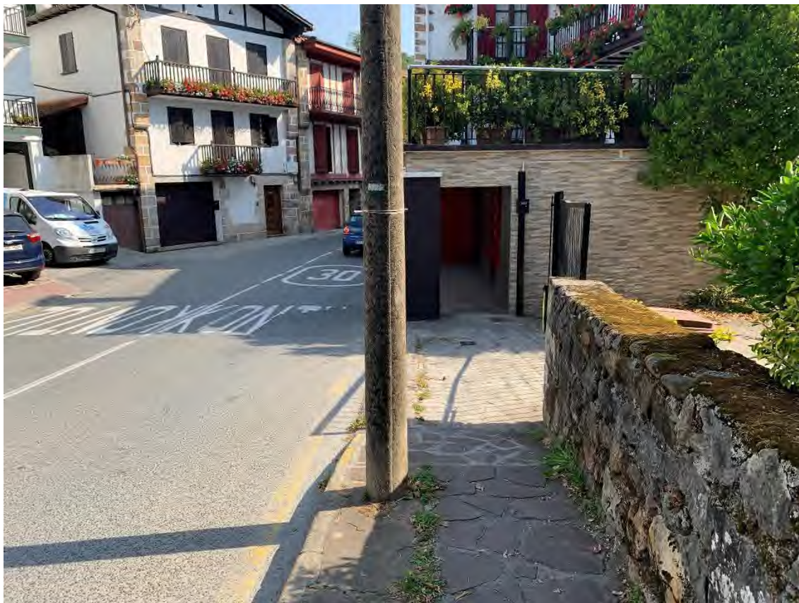
FOTOGRAFÍA 3: Estrechamiento de la acera por poste en ella, además, a poca distancia desaparece.
