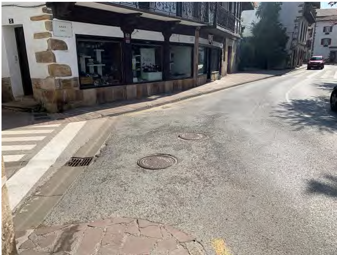
FOTOGRAFÍA 9: Aceras de dimensiones reducidas sin accesibilidad.
