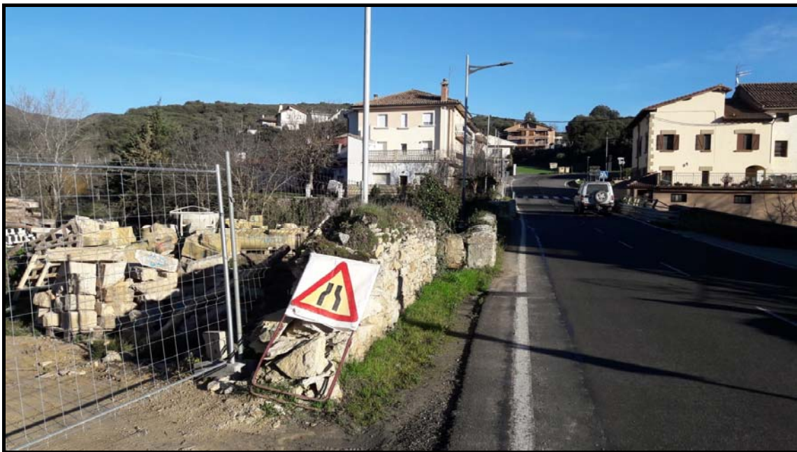
FOTO ACCESO AL PUENTE, CUNETA Y MURO ACTUAL
