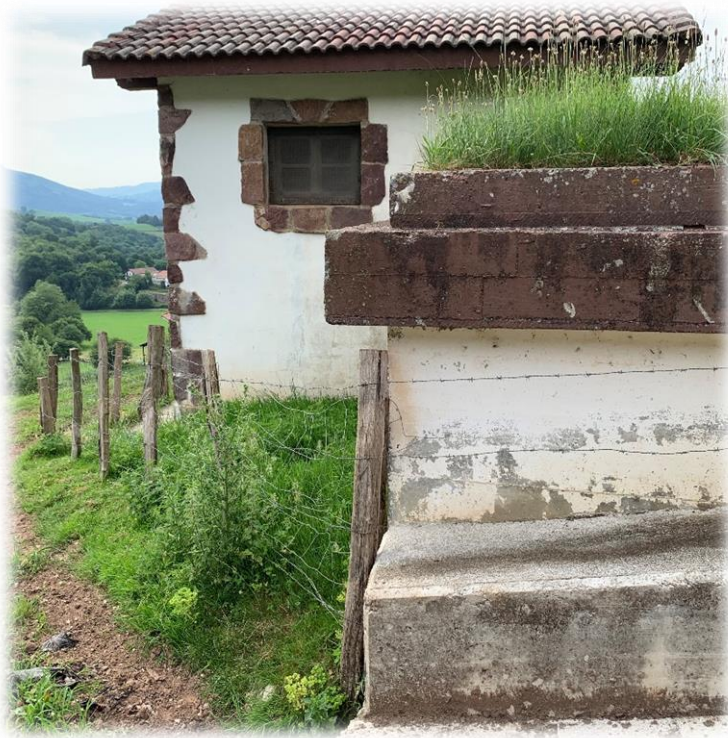
Fotografía 1 – Vista exterior depósito, detalle cubierta.
