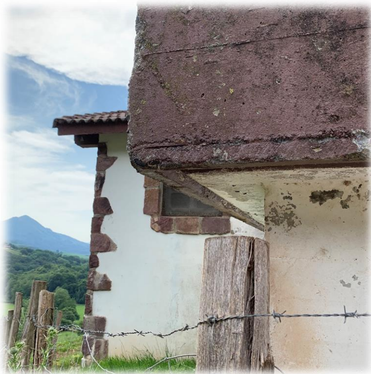
Fotografía 2 – Vista exterior depósito, detalle cubierta.
