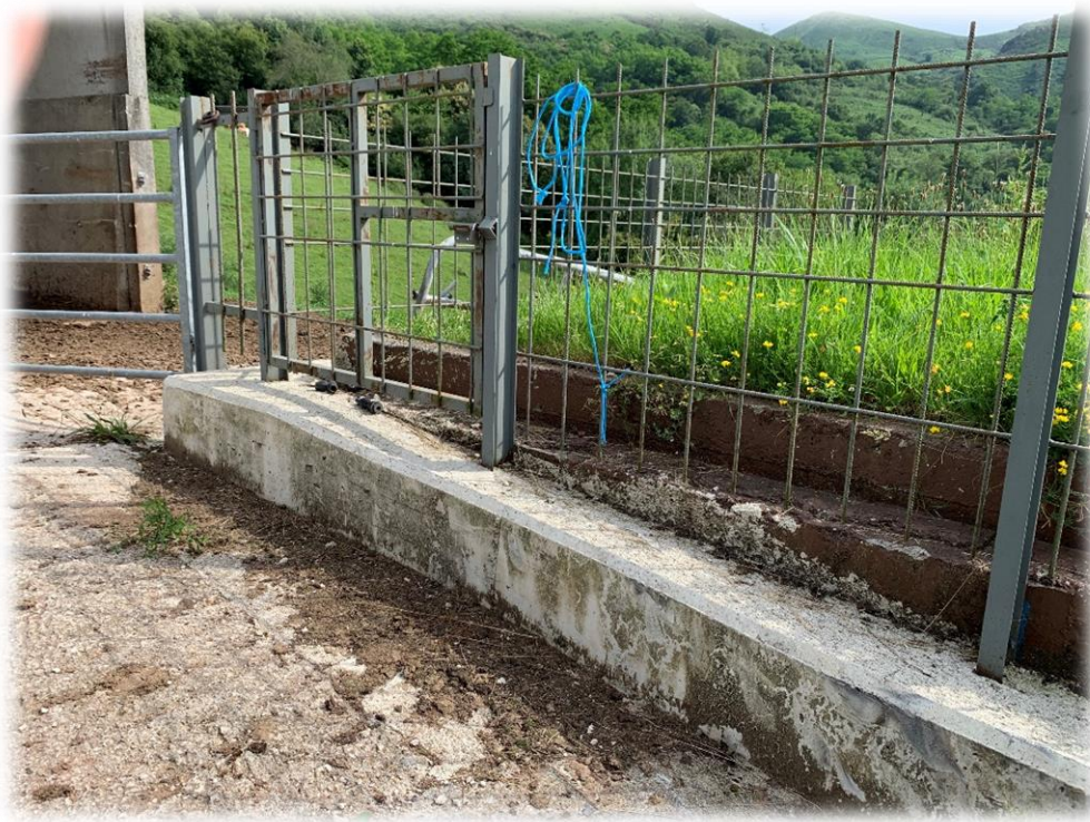
Fotografía 5 – Vista exterior depósito, detalle cierres y cubierta.
