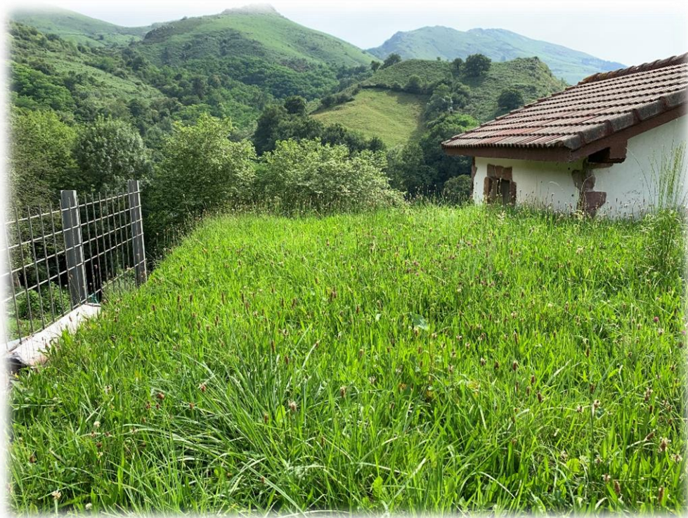
Fotografía 6 – Vista exterior depósito, detalle cubierta.
