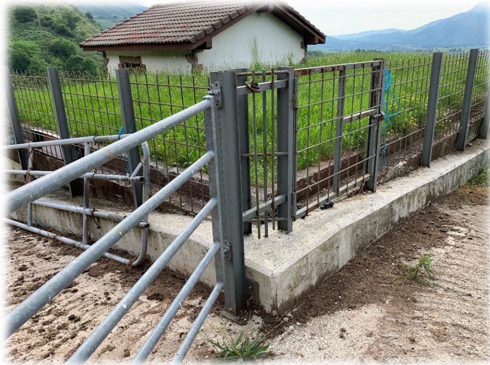
Fotografía 4 – Vista exterior depósito, detalle cierres y cubierta.
