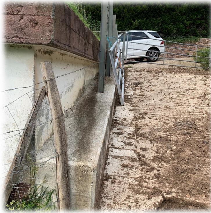
Fotografía 3 – Vista exterior depósito, detalle cubierta.
