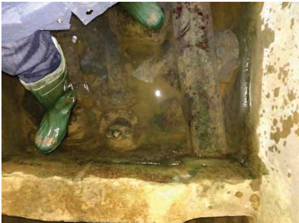
Tuberías existentes dentro de la captación a retirar
