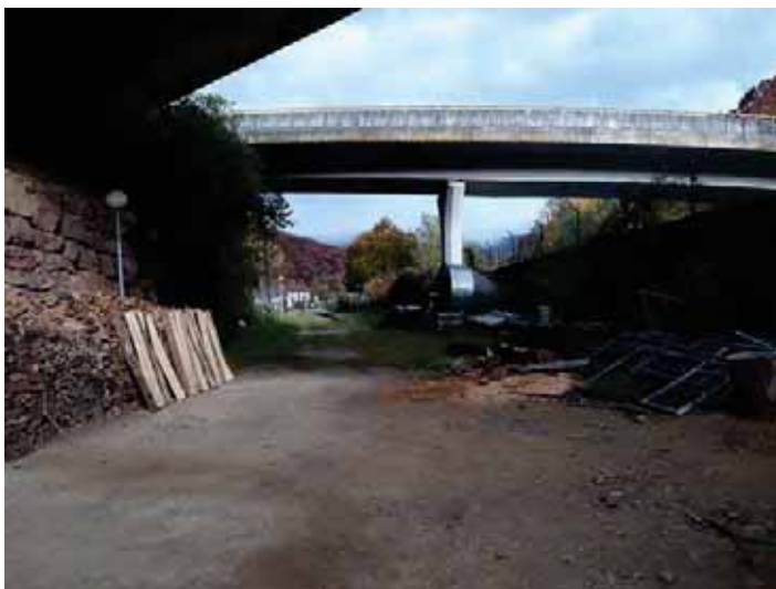
Zona de salida de la piscina de colector de \varnothing 1000.
