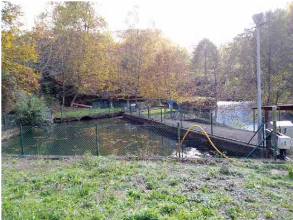
Zona de Muro en la piscina a demoler
