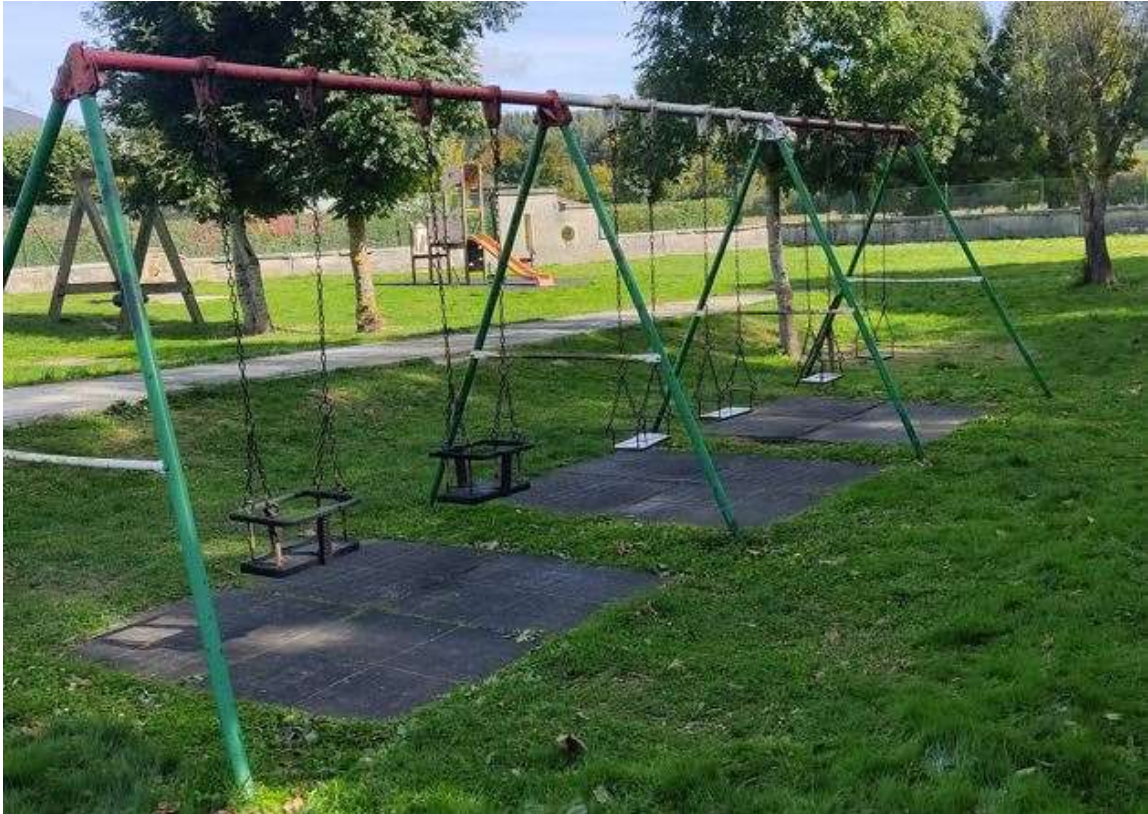
Columpios, con elementos desgastados y oxidados.
