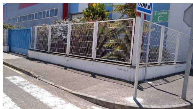
Pasos de peatones ya rebajados
