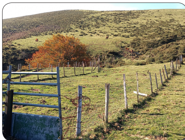
Recinto a mejorar
