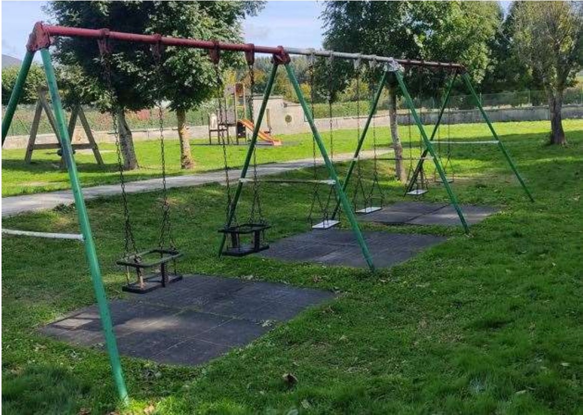
Columpios, con elementos desgastados y oxidados.
