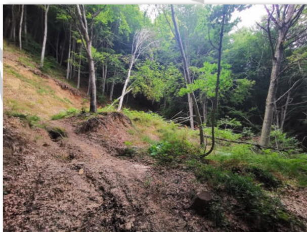
Ilustración 11.- Zona de derrumbe
