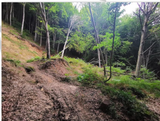
Ilustración 3.- Desprendimiento en un vial del Camino de Legarogi
