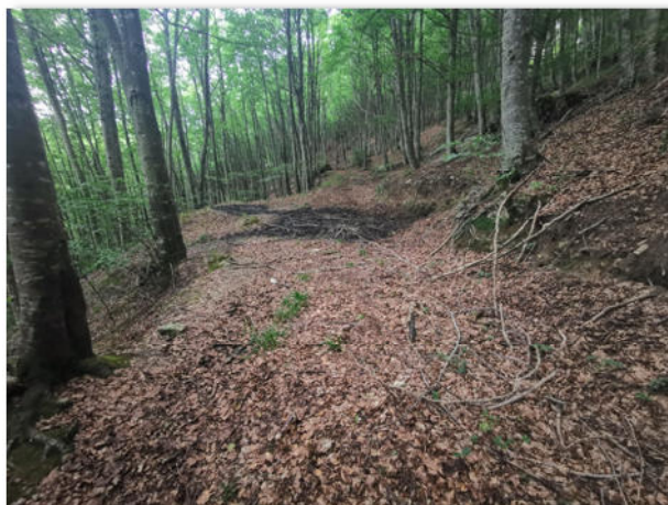
Ilustración 12.- Tramos 5 y 7 presentan zonas de acumulación de agua en las que es necesaria la ejecución de sangraderas.
