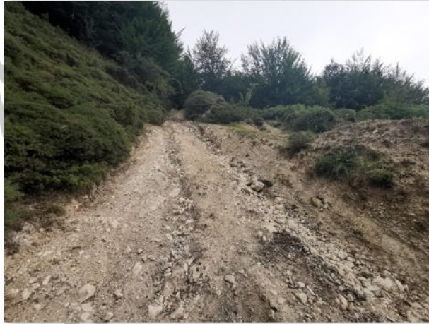
Ilustración 9.- Tramo 2. Zona de fuerte excavación y reconstrucción de la plataforma del camino.
