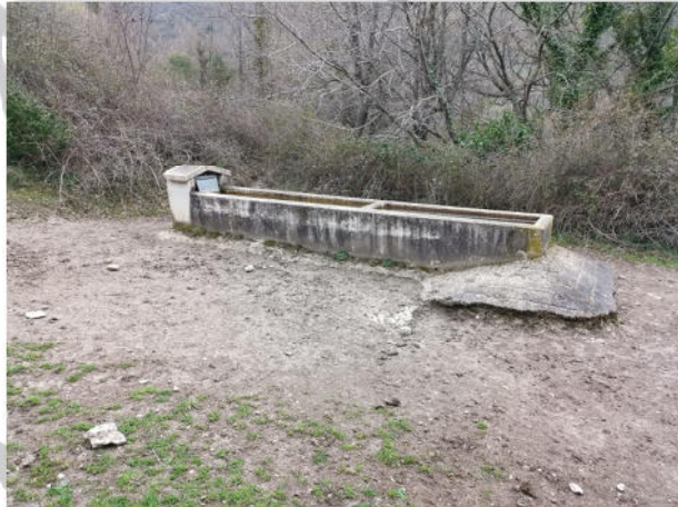
Ilustración 5.- Abrevadero con postizo hormigonado
