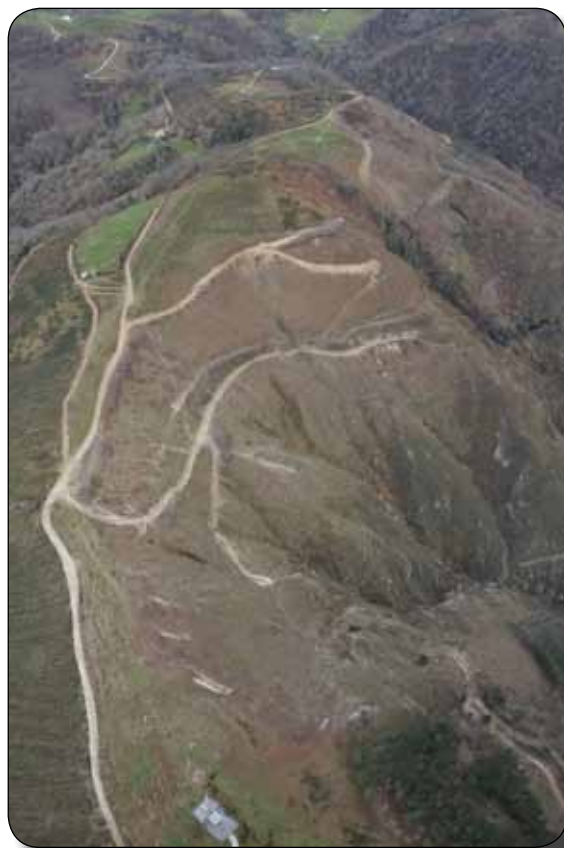
Vista aérea desde el NE hacia el SE
