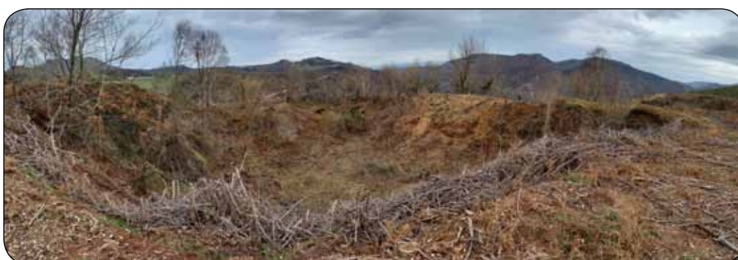
Socavón situado junto al recinto 2 y excluido de la repoblación
