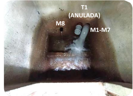
F23 Fotografías de la Caseta de Reunión R4. Entrada M1-M7 (M1-M6 en uso), M8 y antigua toma T1 auxiliar de cauce (anulada)
