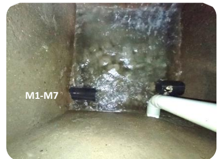
F27 Fotos Caseta de Reunión R5. Entrada M1-M7 (M1-M6 en uso), entrada M9 y entrada M10 (tubo blanco)
