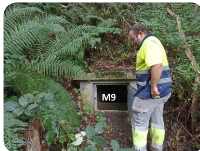
F24 Caseta del Manantial M9. Válvula corte integrada en caseta y "alcachofa" de toma. Vaguada afluente secundario
