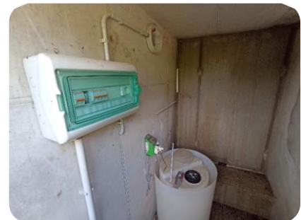
F11 Interior caseta cloración. Zócalo zapata vaso 40cm en fondo
