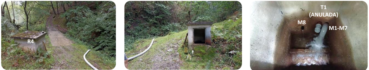
F23 Fotografías de la Caseta de Reunión R4. Entrada M1-M7 (M1-M6 en uso), M8 y antigua toma T1 auxiliar de cauce (anulada)
