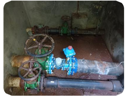
F3 Detalle cámara de llaves
