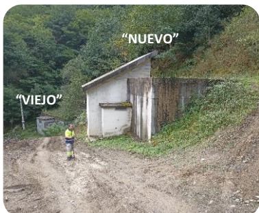
F7 Acceso dep “nuevo”
