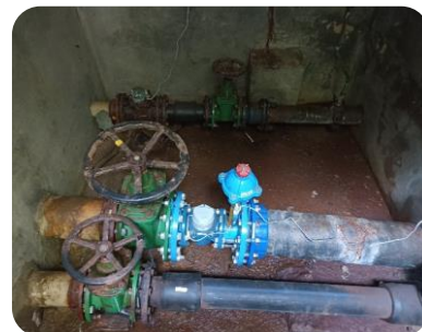
F3 Detalle cámara de llaves
