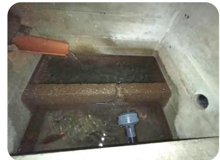
F23 Fotografías de la Caseta del Manantial M8. Válvula corte integrada en caseta y "alcahofa" de toma
