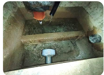
F24 Caseta del Manantial M9. Válvula corte integrada en caseta y "alcachofa" de toma. Vaguada afluente secundario
