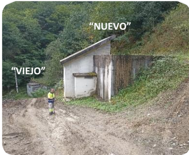
F7 Acceso dep “nuevo” aguas arriba
