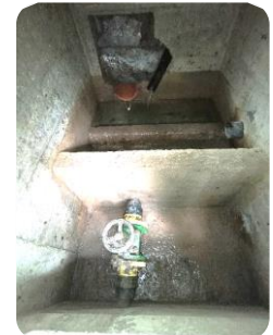
F24 Caseta del Manantial M9. Válvula corte integrada en caseta y "alcachofa" de toma. Vaguada afluente secundario
