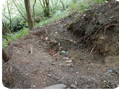
F26 Catas para localización atasco en ramal PVC. Atasco entre cata 1 y Cata 2
