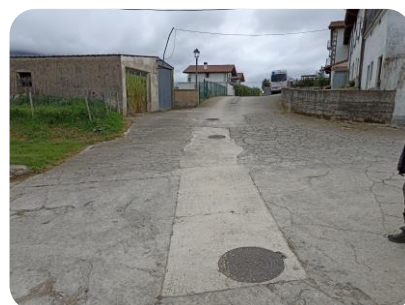
F21 Vista a c/Kattanburu zona renovada
