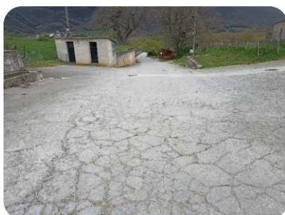
F20 Tramo hor c/San Vicente nº36-dep
