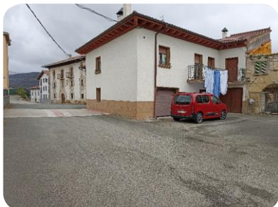
F15 c/San Vicente nº24 y paso elevado
