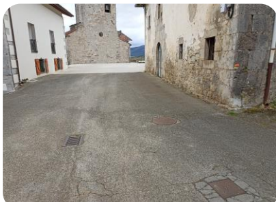
F5 Pav. asf con sumideros hacia iglesia
