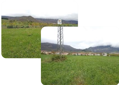
F1 Entrada abast baja actual por camino
