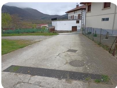
F23 Tramo hor bajada c/S.Vicente nº27
