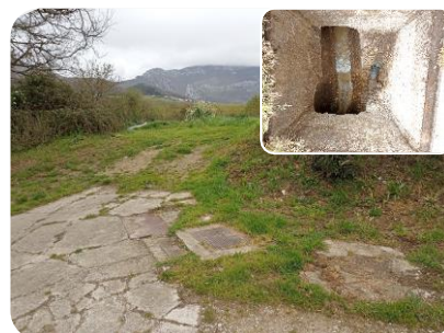
F23 Salida emisario unit. Ramal Norte
