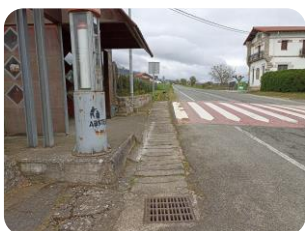
F6 Cuneta y soterramiento pluviales en MI (Sur) ctra. NA-2410
