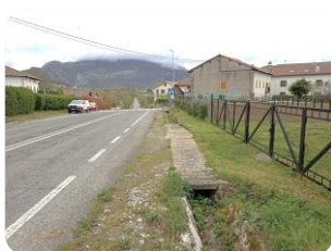
F6 Cuneta y soterramiento pluviales en MI (Sur) ctra. NA-2410
