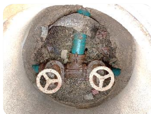
F2 Red de abastecimiento en baja con PVC presión
