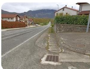
F6 Cuneta y soterramiento pluviales en MI (Sur) ctra. NA-2410
