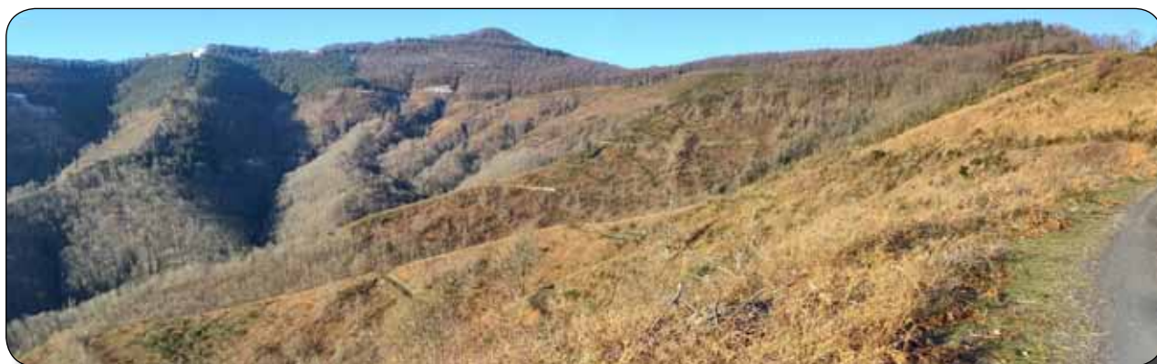
Pista en loma y disposición en ladera SSE
