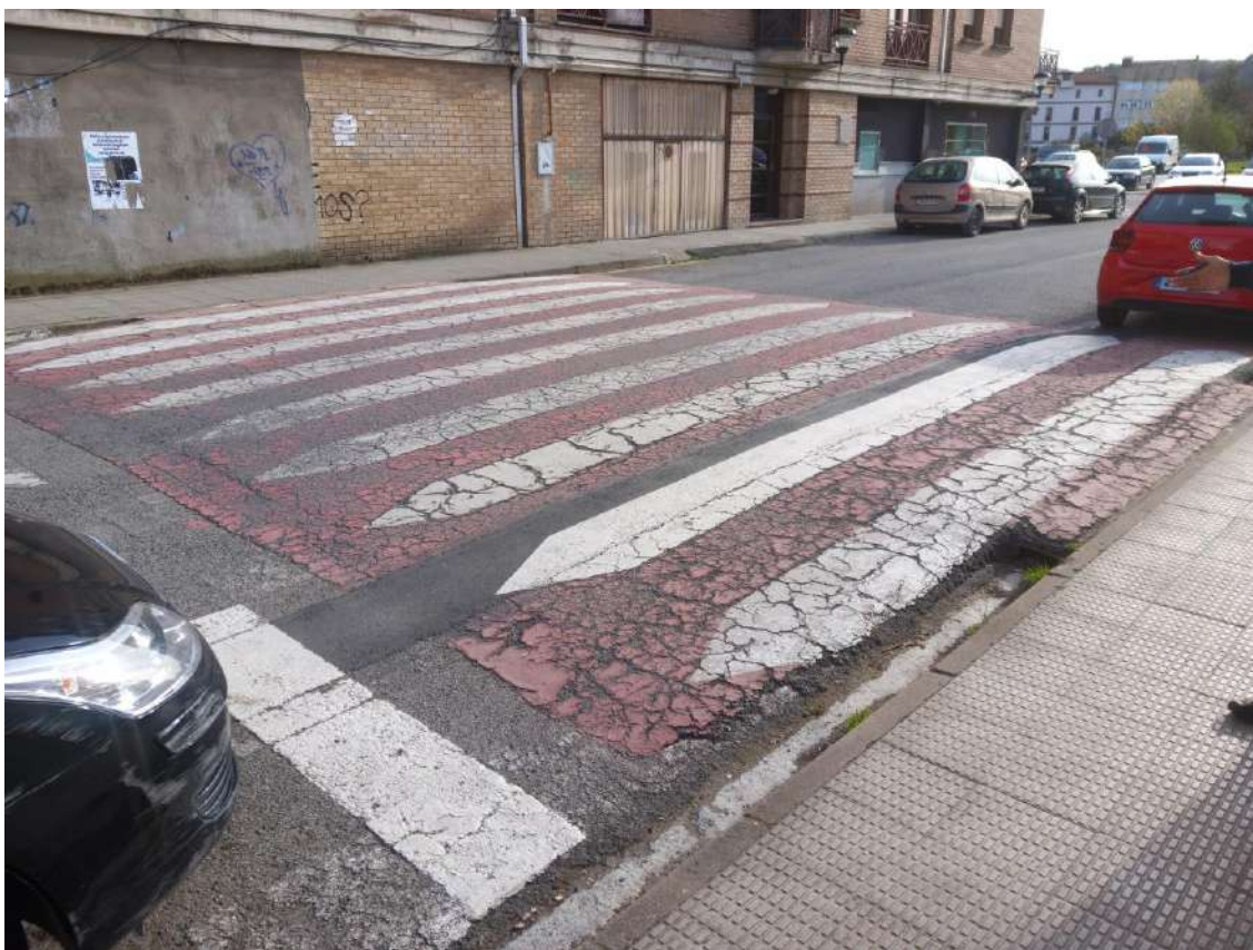
FOTOGRAFÍA 13. PASO PEATONES CALLE SAN JUAN
