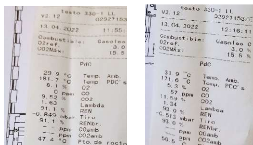
Rendimientos de combustión de las calderas
