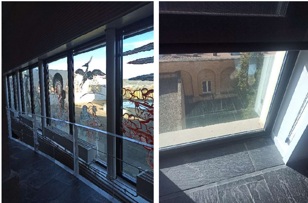
Ventanales en planta baja y ventanas zona de exposición
