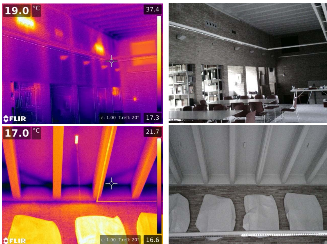
Fig.48. Termografías e imagen digital interiores de la sala de didáctica: fachadas (puentes térmicos y rejillas), y cubierta (2/12/2019)
