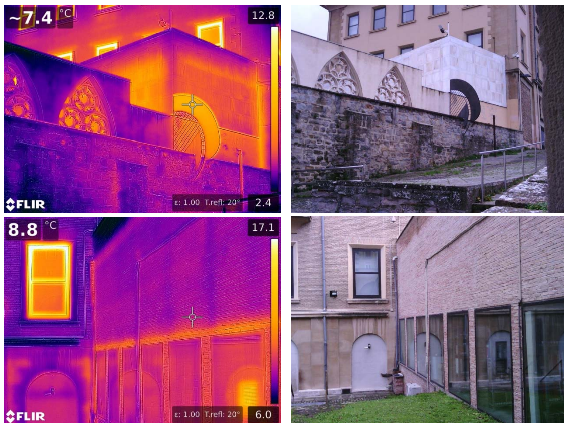
Fig.47. Termografías e imagen digital exteriores de la sala de didáctica (2/12/2019)
