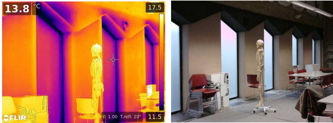
Fig.49. Termografías e imagen digital interiores de la sala de didáctica en planta baja: durante el ensayo de puerta ventilador (9/12/2019)
