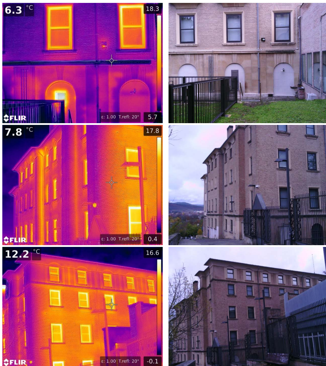
Fig.46. Termografías e imágenes digitales exteriores del ala expositiva del MN (2/12/2019)
