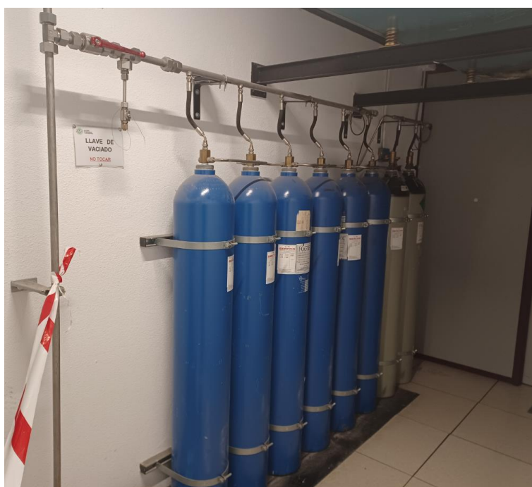
Figura 27: Bombonas del sistema de agua nebulizada
