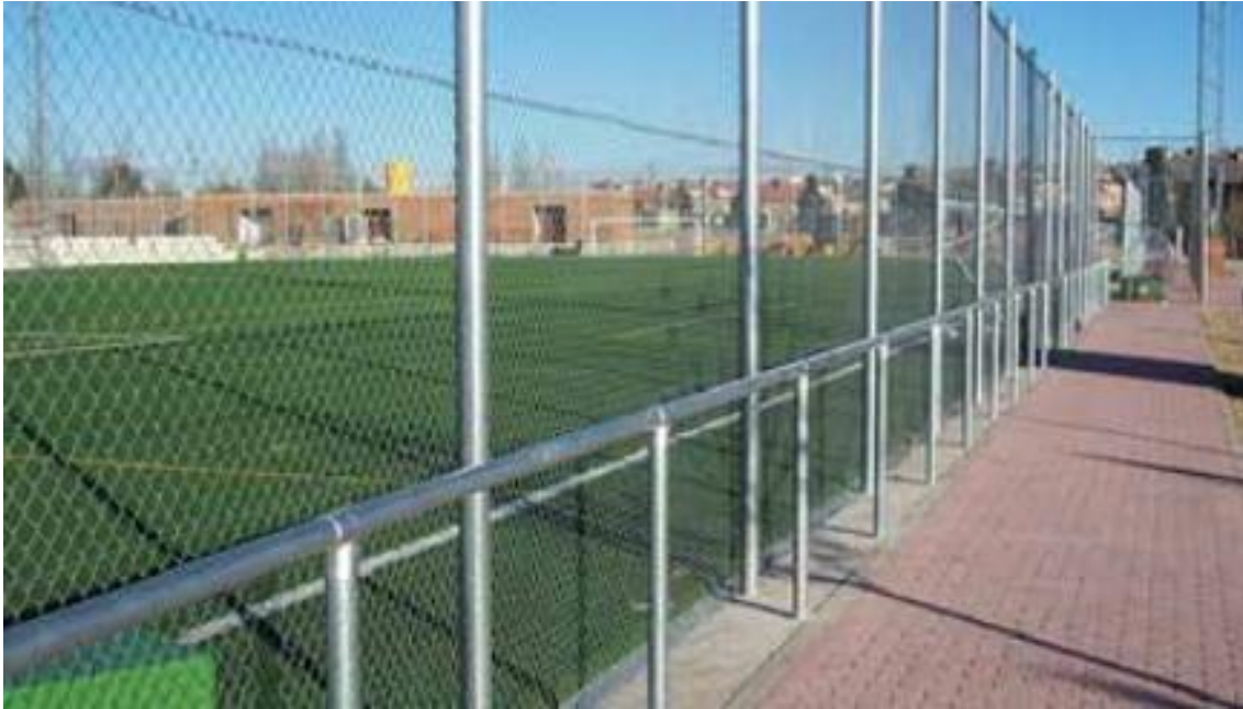
Cierre perimetral de la pista formado por malla de simple torsión en la parte inferior, y malla de poliamida reforzada en su parte superior.
