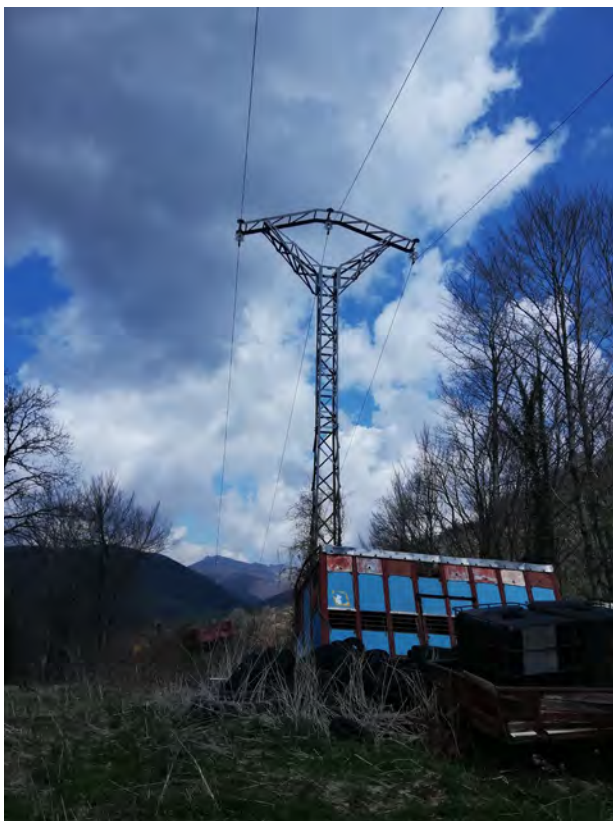
Apoyos nº : 4 -5-6 y 7
