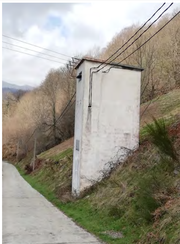
Apoyo nº: CT 3
