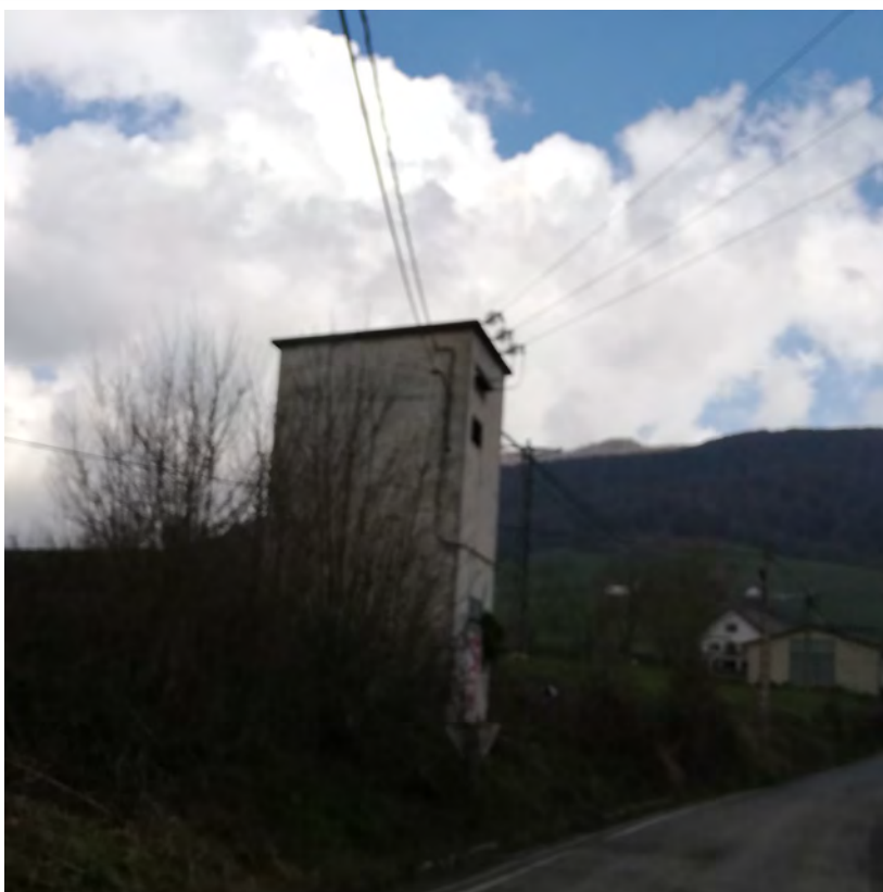
Apoyo nº: CT 2
