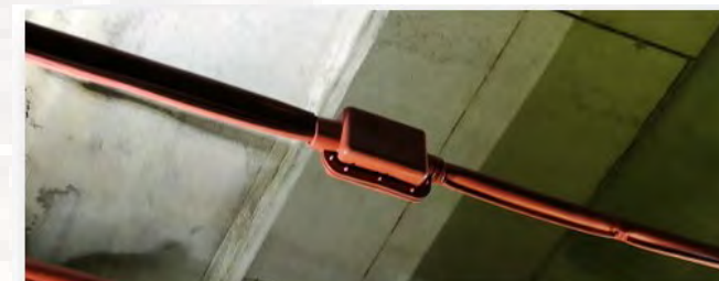
SPSM. Uso en Suspensión de Ménsulas. Montaje de conjunto de forros modelos SPSM-SWP12-SWP28 .
