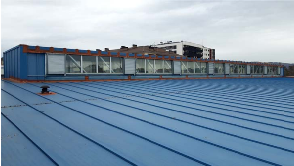
Cubierta de trabajo para colocar los vinilos del lucernario
