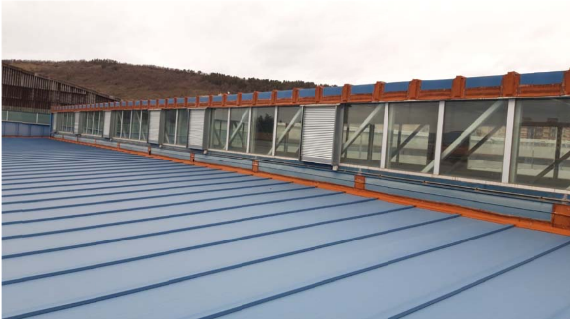
Vista del lucernario existente en cubierta ubicado centrado en la pista y recorriéndola longitudinalmente con acristalamiento por ambas caras.
