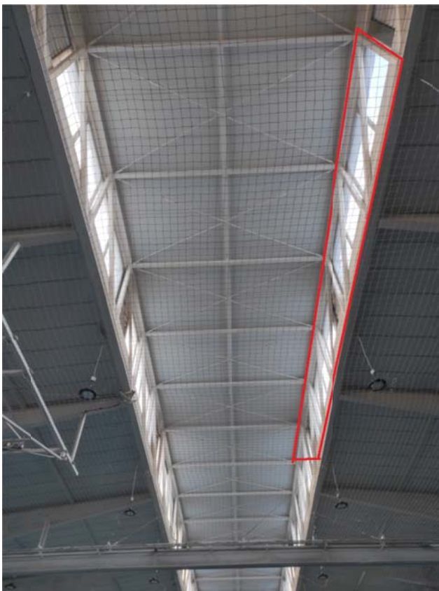
Vista interior del lucernario. Protegido mediante redes para proteger la cubierta de posibles balonazos.
