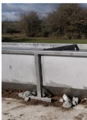
Ilustración 5: Detalle pata a la altura de la base del abrevadero
