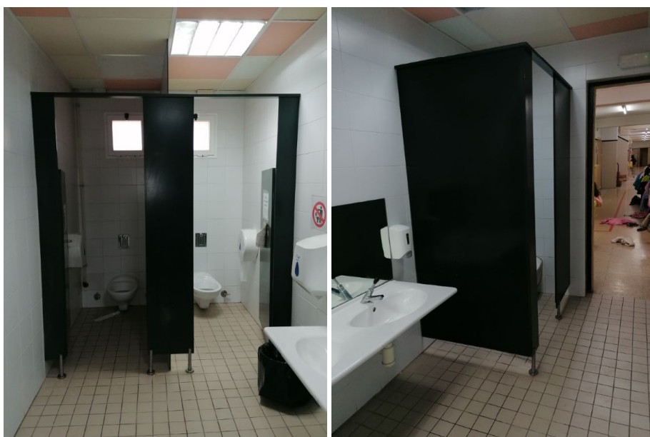
Aseo renovado recientemente a adecuar
