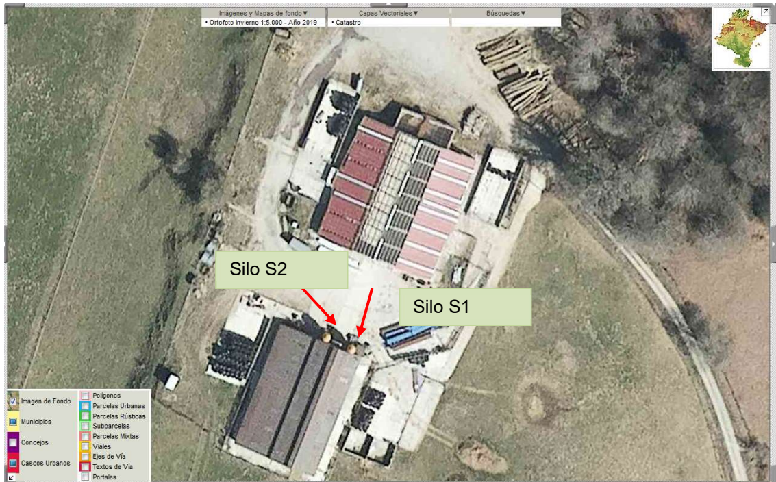
Figura 4. Denominación de silos de recepción y almacenamiento de concentrado. Área de Soroluze
