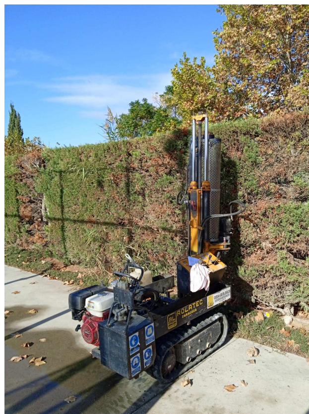
Ensayo de penetración dinámica P2
