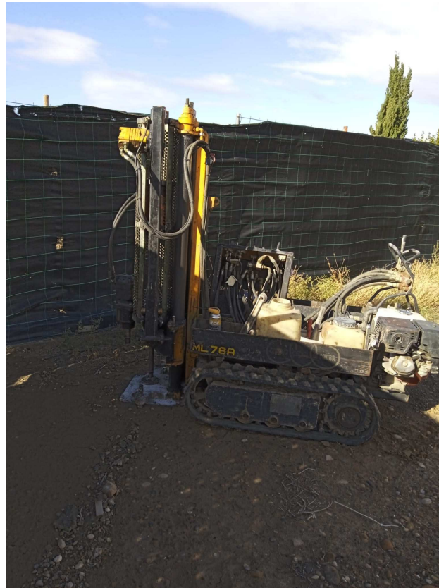
Ensayo de penetración dinámica P1
