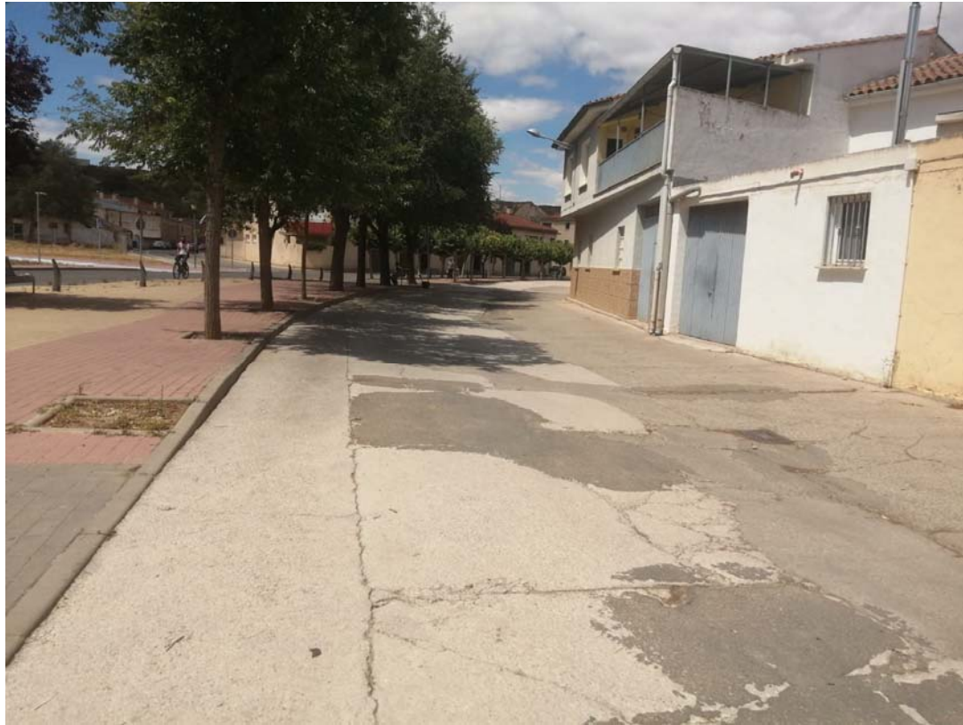
- Fotos 2, 3 y 4: Estado muy deficiente calzada, e inexistencia de aceras en zona de viviendas
