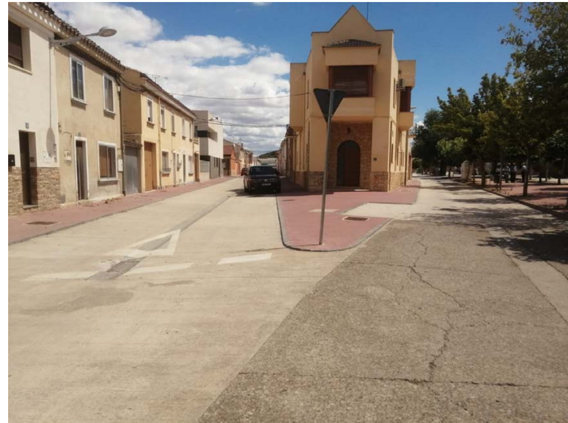
- Foto 1: Inicio de la pavimentación y nuevas redes. Frente a la calle Virgen del Soto (aproximadamente)
