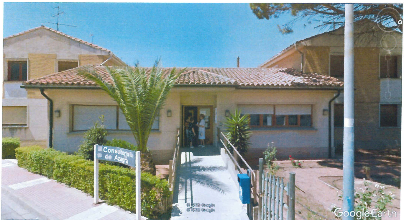
2 viviendas para médicos y, entre ambas, el dispensario
