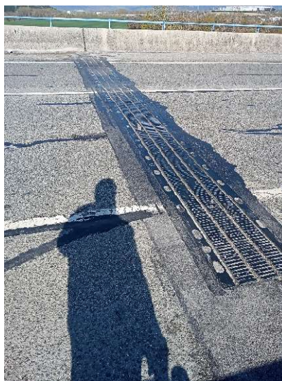
Imagen 12. Junta de dilatación de puente sobre río Arga
