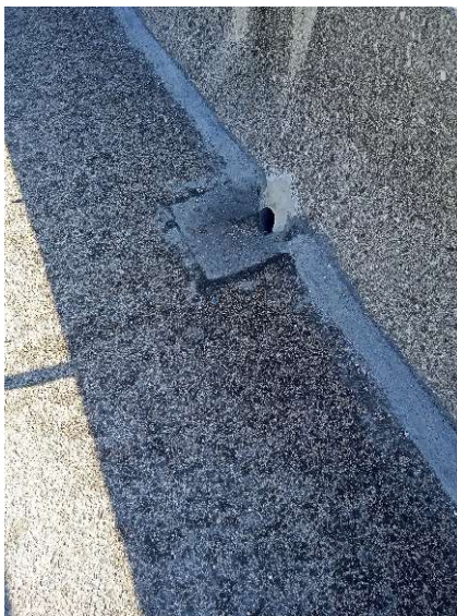
Imagen 11. Drenaje del tablero del puente sobre río Arga
