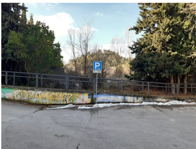
Fotografía 4.- Zona de conexión del vial de acceso. Muro y acera a demoler.
