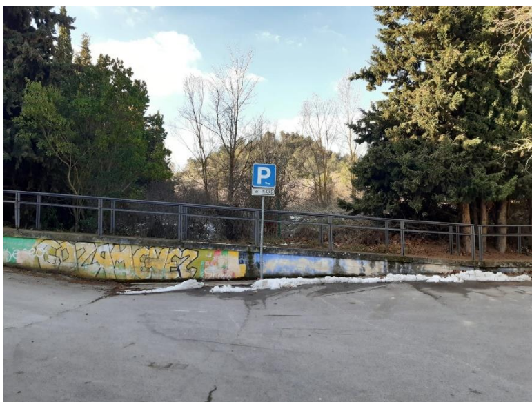
Fotografía 4.- Zona de conexión del vial de acceso. Muro y acera a demoler.
