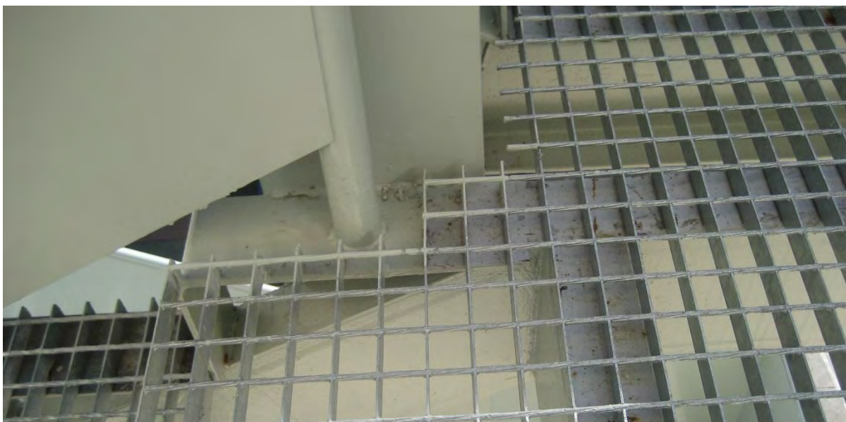
Detalle de la rejilla que conforma el piso de los rellanos y escalera.
