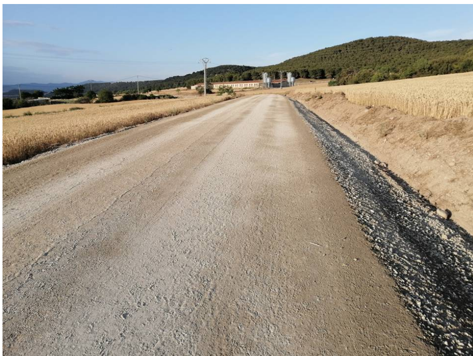
Vista de camino a asfaltar, con todo –uno compactado Diciembre 2022
