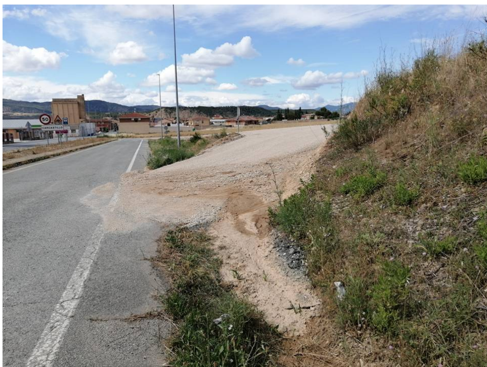
Vista de camino a asfaltar . Encuentro con carretera Carcastillo-Figarol. Lugar de colocación de tubería 40 cm diámetro para continuación de cuneta.
