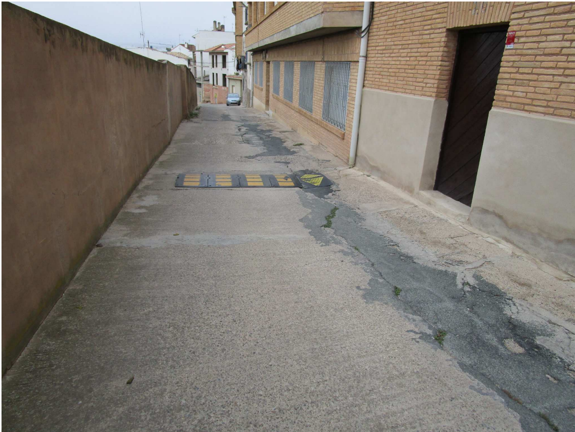
Fotografía 2: c/ Muro Alto, punto aguas arriba red de saneamiento.
