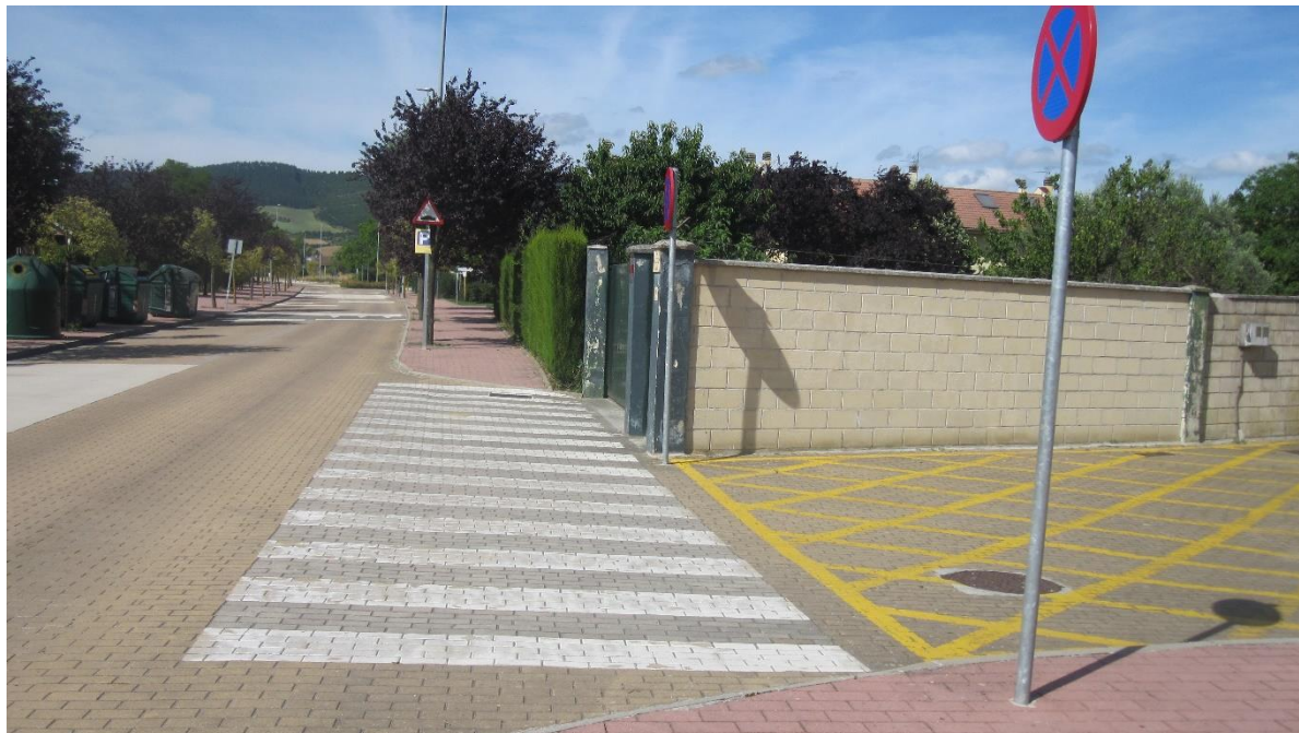
16.- Paso de peatones a nivel en zona de acceso de suministros al Polideportivo y señalización horizontal de dicho acceso
