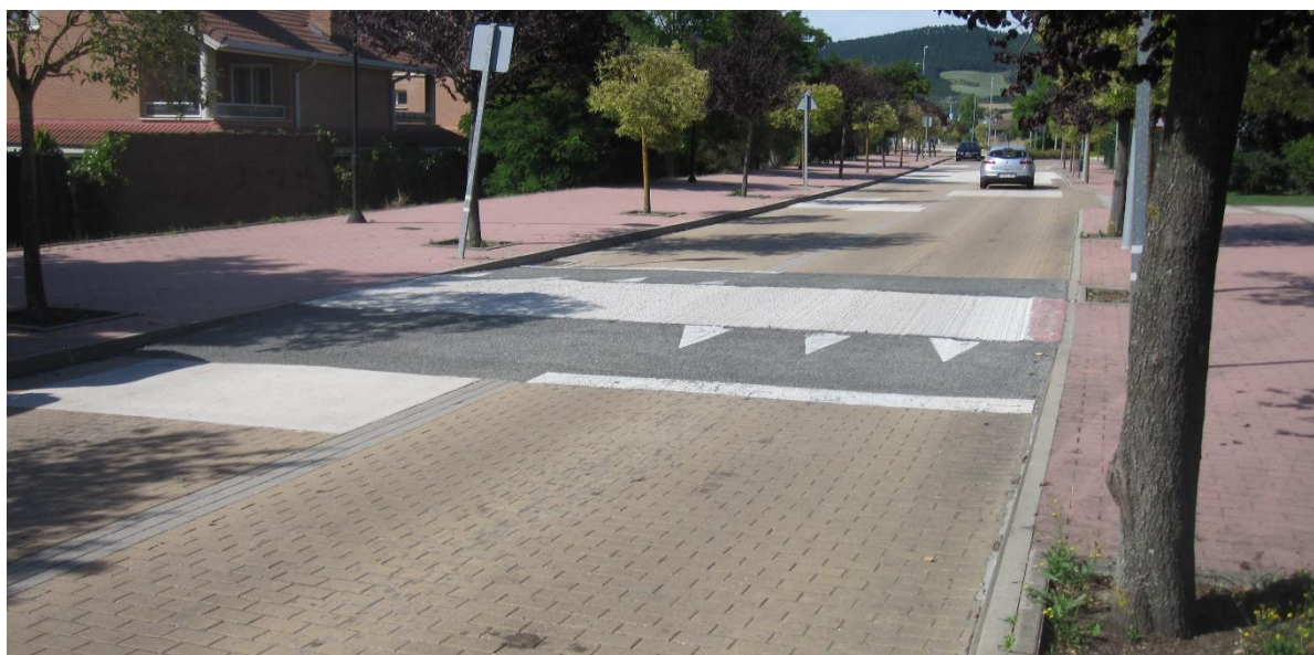
18.- Paso de peatones elevado con ajuste adecuado de las aceras y drenaje. A mantener su disposición
