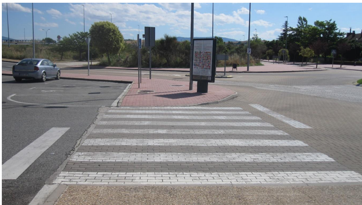
14.-Paseo de peatones a nivel en el acceso al aparcamiento del Polideportivo
