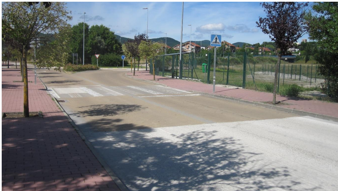
20.- Paso de peatones a nivel en la llegada a la glorieta no circular
