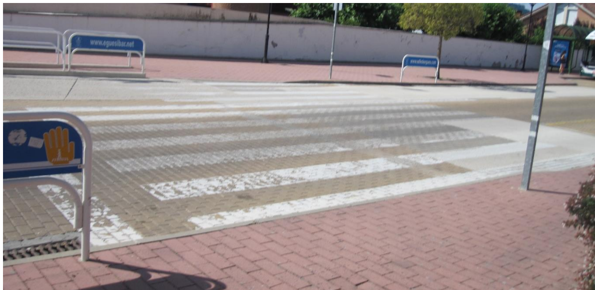
15.- Paso de peatones a nivel en el comienzo del vial de conexión entre las dos glorietas. Con avance de las líneas en la zona del Polideportivo
