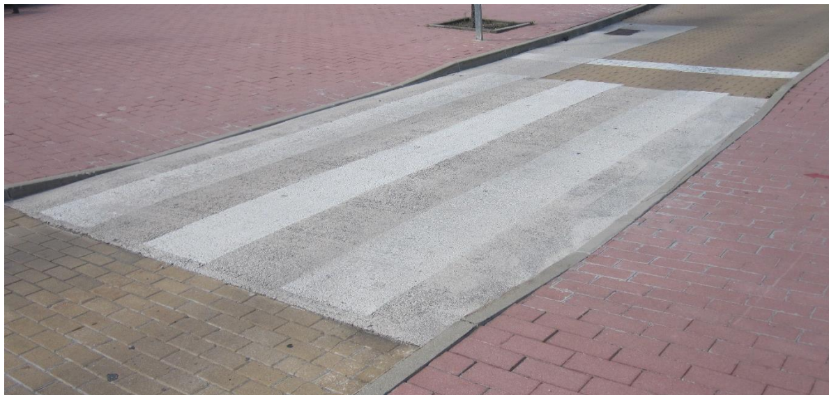
11.- Paso de peatones anterior a la glorieta. A nivel. Se ha previsto incrementar su longitud con la modificación de la acera y la disposición de dos carriles de circulación
