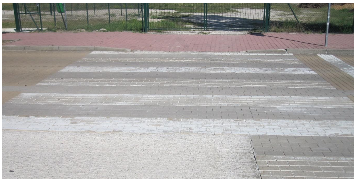
21.- Paso de peatones anterior desde uno de sus extremos. Se puede apreciar el rebaje de los bordillos y la zona reparada con sustitución de adoquines por hormigón
