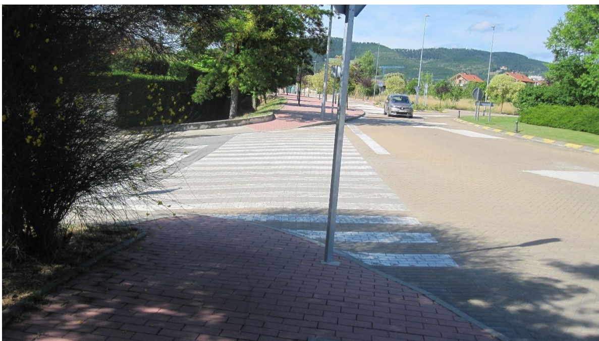
23.- Paso de peatones a nivel en el acceso al casco urbano desde la glorieta principal
