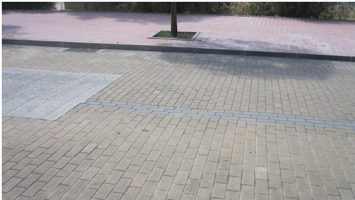
7.- Rejilla en acera izquierda. Todo este tramo tiene la pendiente transversal hacia dicha acera
