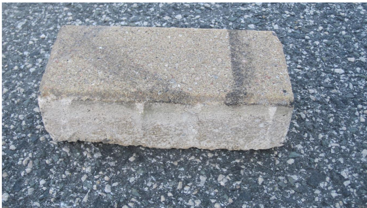
29.- Detalle del adoquín utilizado en la calzada (20 x 10 x 6 cm)
