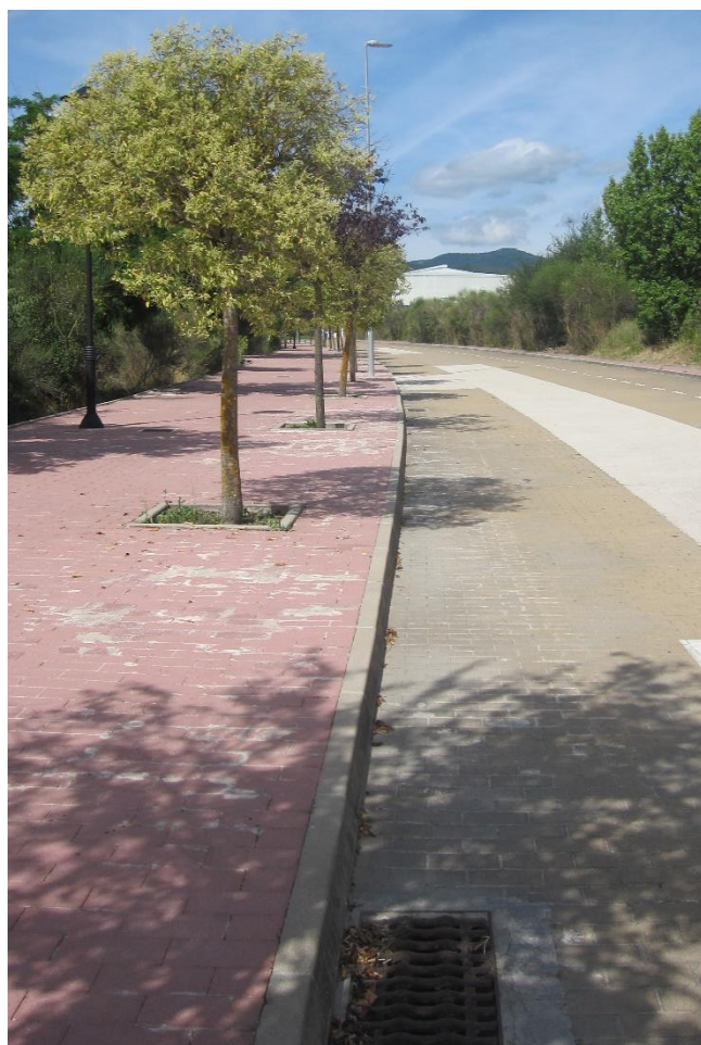
4.- Acera izquierda en sentido del avance. Rejilla en esta zona por tener la calzada la pendiente transversal hacia esta acera
