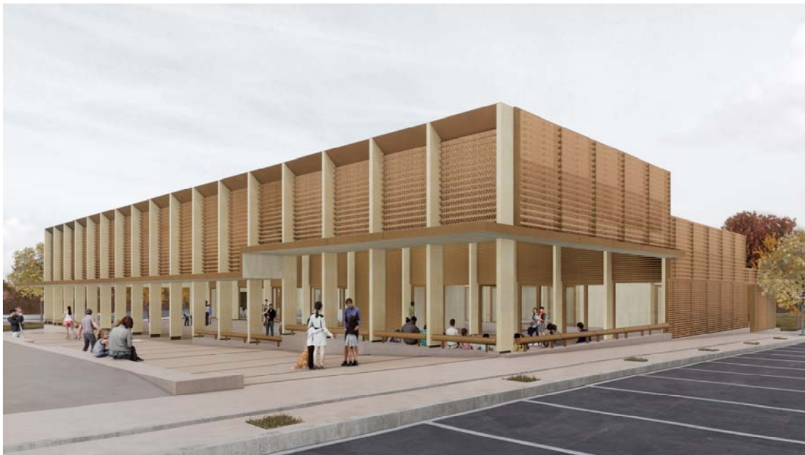
Vista general del edificio, desde el sureste, desde el acceso próximo a la plaza Arbide
