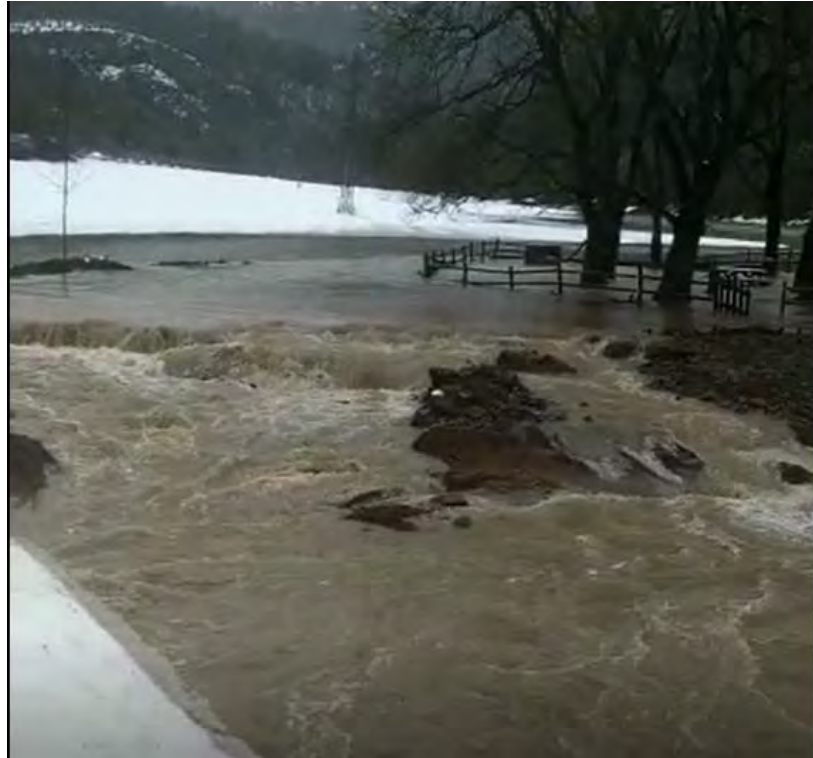
Retorno aguas avenida diciembre 2021, aguas arriba puente
