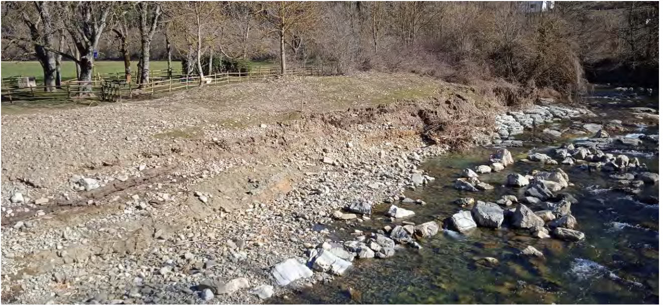
Aspecto previo actuación 2022, margen derecha, aguas arriba puente
