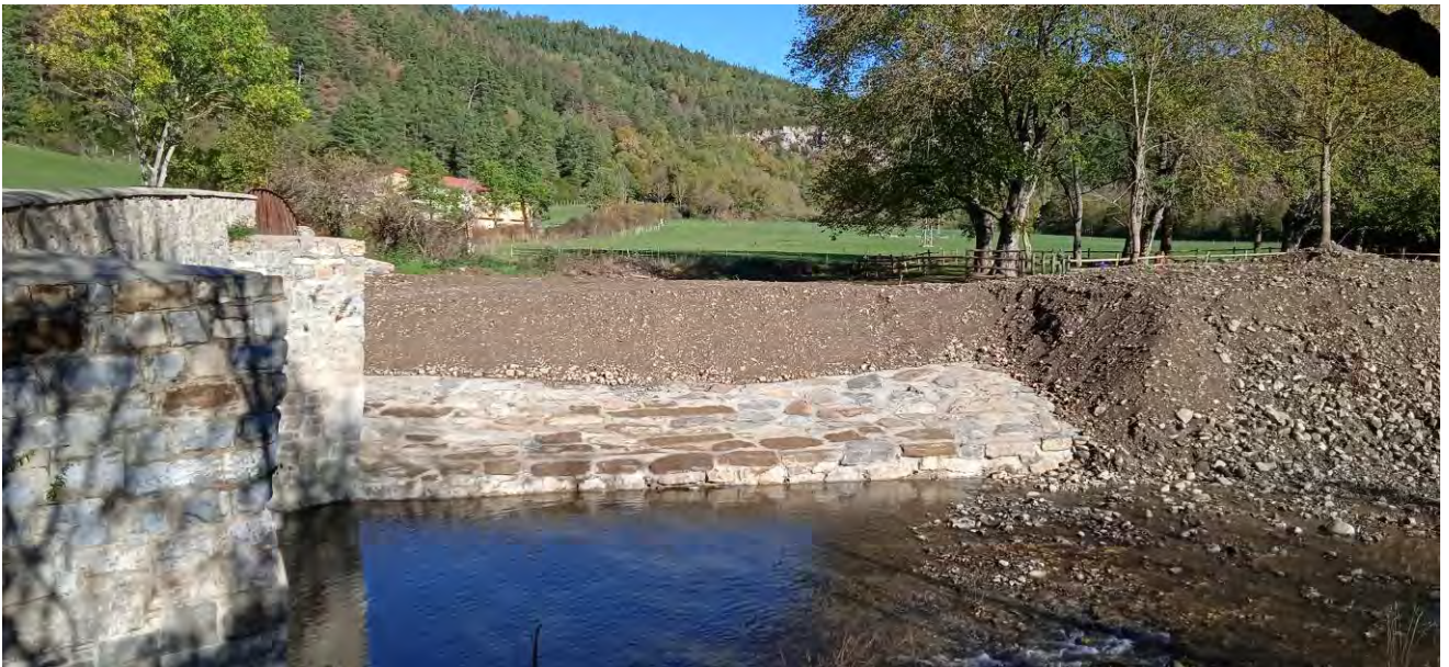
Aspecto tras actuación 2022, margen derecha, aguas arriba puente
