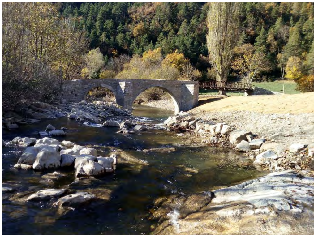
Aspecto obra desde aguas arriba, finalización obra fase noviembre 2021
