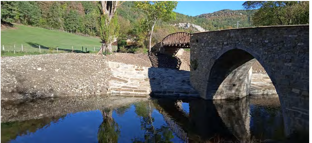
Imagen tras actuación 2022, margen derecha, aguas abajo puente
