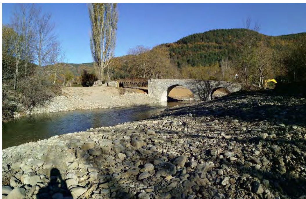
Aspecto obra desde aguas abajo, finalización obra fase noviembre 2021
