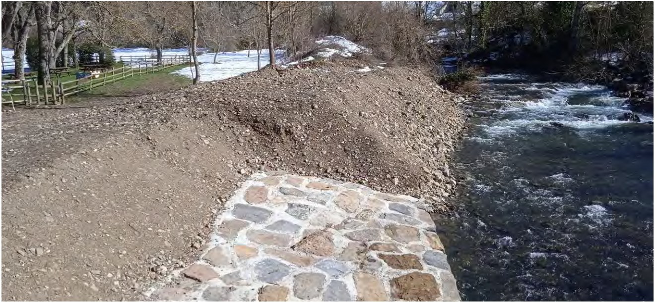
Aspecto actual margen derecha, aguas arriba puente
