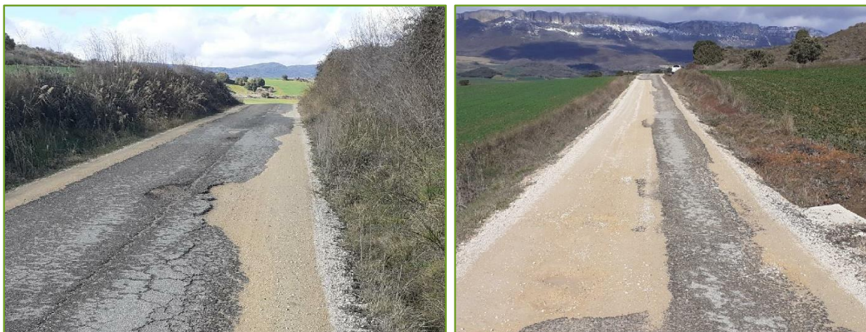
Tramos degradados en los que se realizará una regularización previa al afirmado
