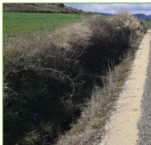
Tramo de cuneta objeto de limpieza
